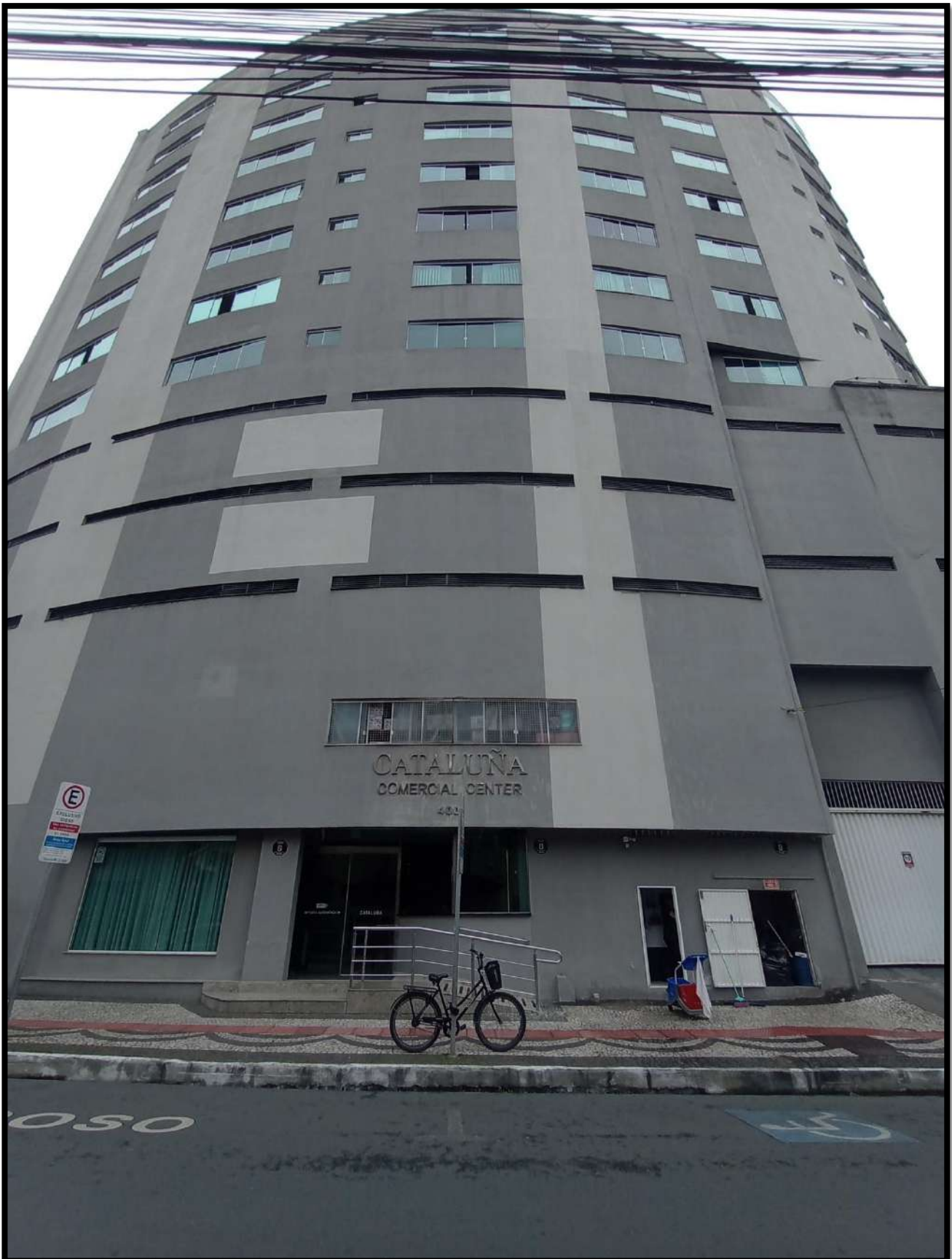
FAIXADA DO PRÉDIO QUE CONTEM O IMÓVEL OBJETO DESTA PERÍCIA JUDICIAL
