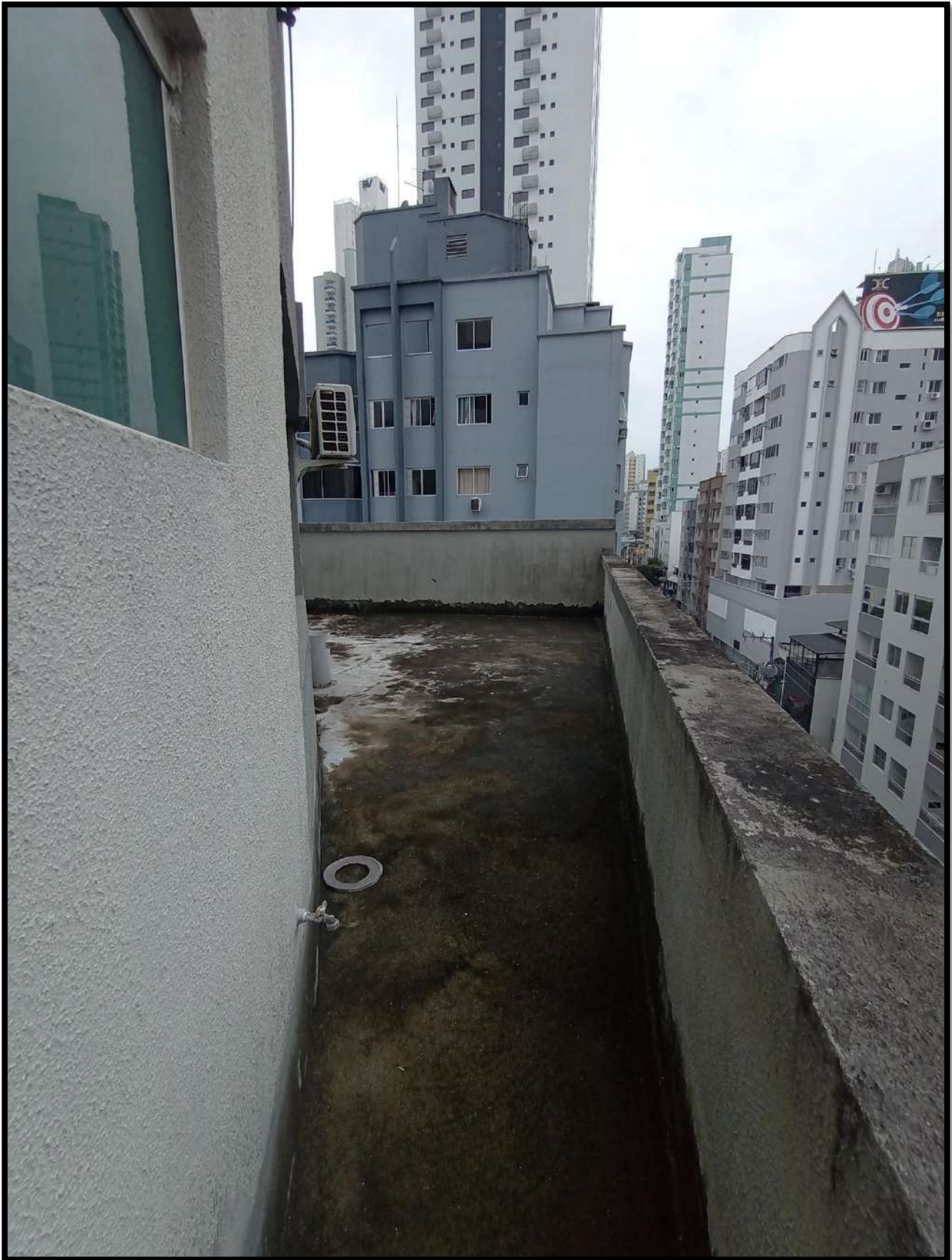
LATERAL DO TERRAÇO VOLTADA PARA RUA 901
