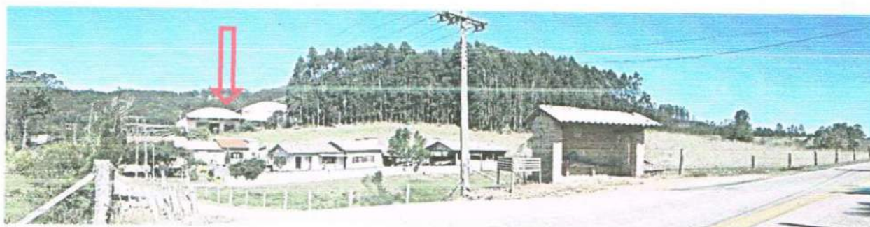
Vista da SC-441
