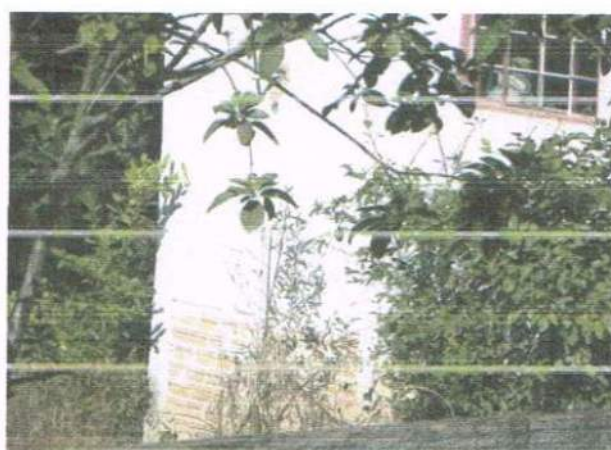
Detalhe parede lateral
