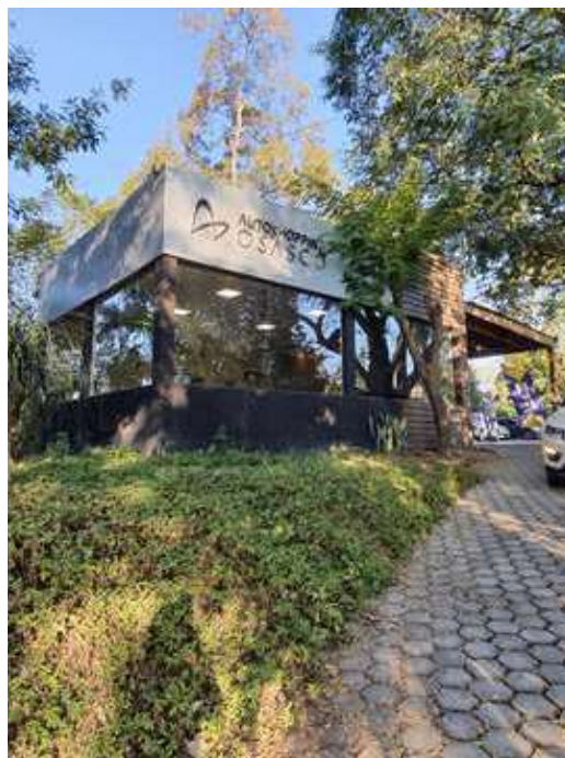
37- Vista Edificação à partir pista descida
