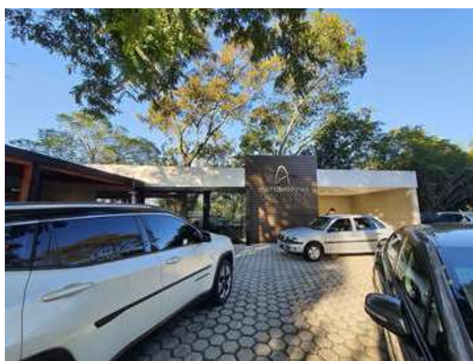
29- Edificação Auto Shopping Osasco
