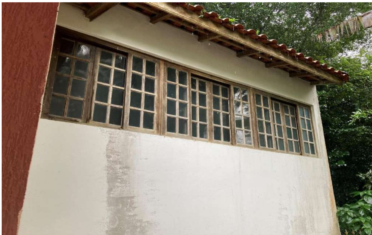
Estrutura sala de estar
