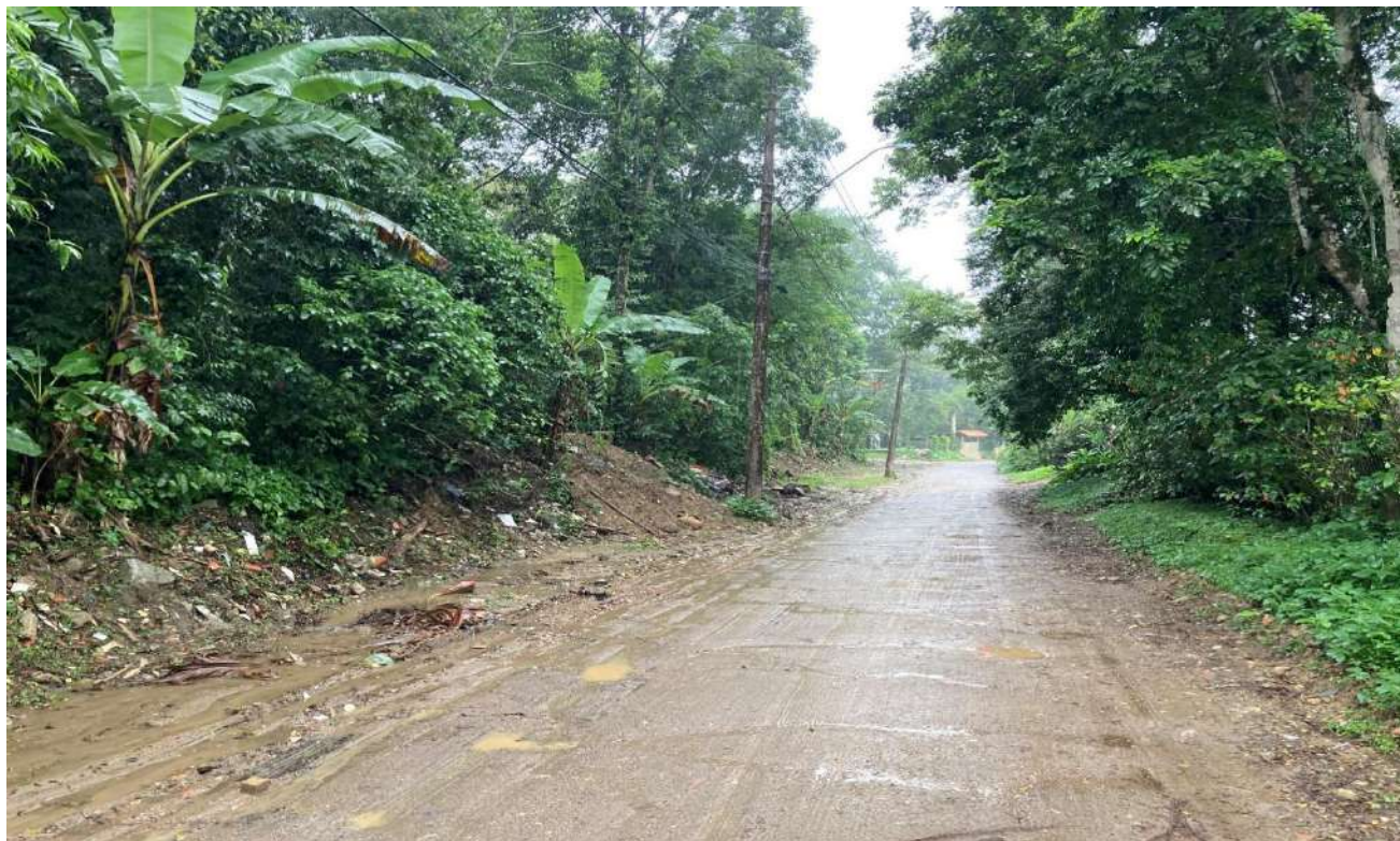
Sem pavimentação – acesso precário por vias de terra
