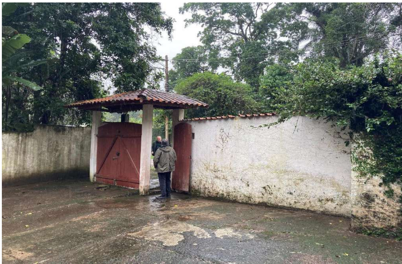
Garagem – muro frontal
