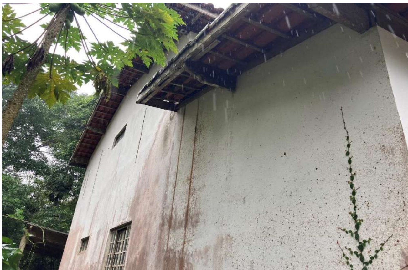
Estrutura lateral esquerda
