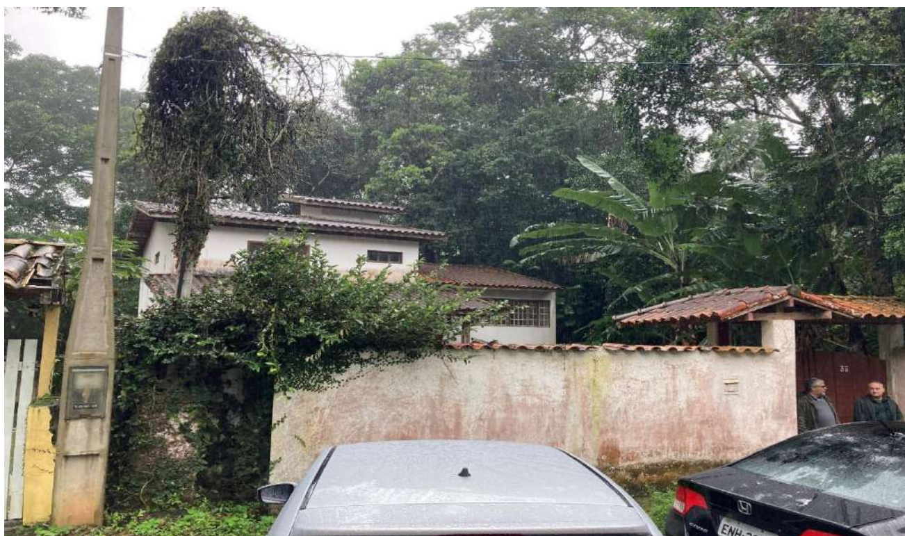
Posteamento do imóvel padrão antigo de água/energia
