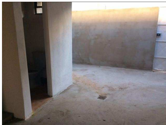
Foto 7. Outra vista dos fundos do imóvel paradigma.
