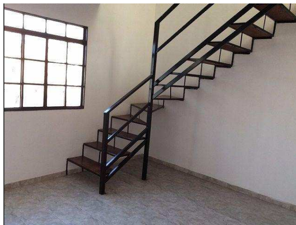
Foto 3. Vista da área interna do imóvel paradigma. Observa-se aí, cômodo correspondente à sala, e escadaria de acesso ao pavimento superior.
