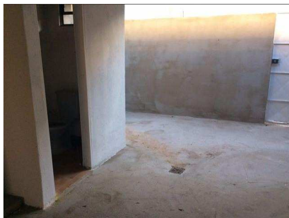
Foto 7. Outra vista dos fundos do imóvel paradigma.
