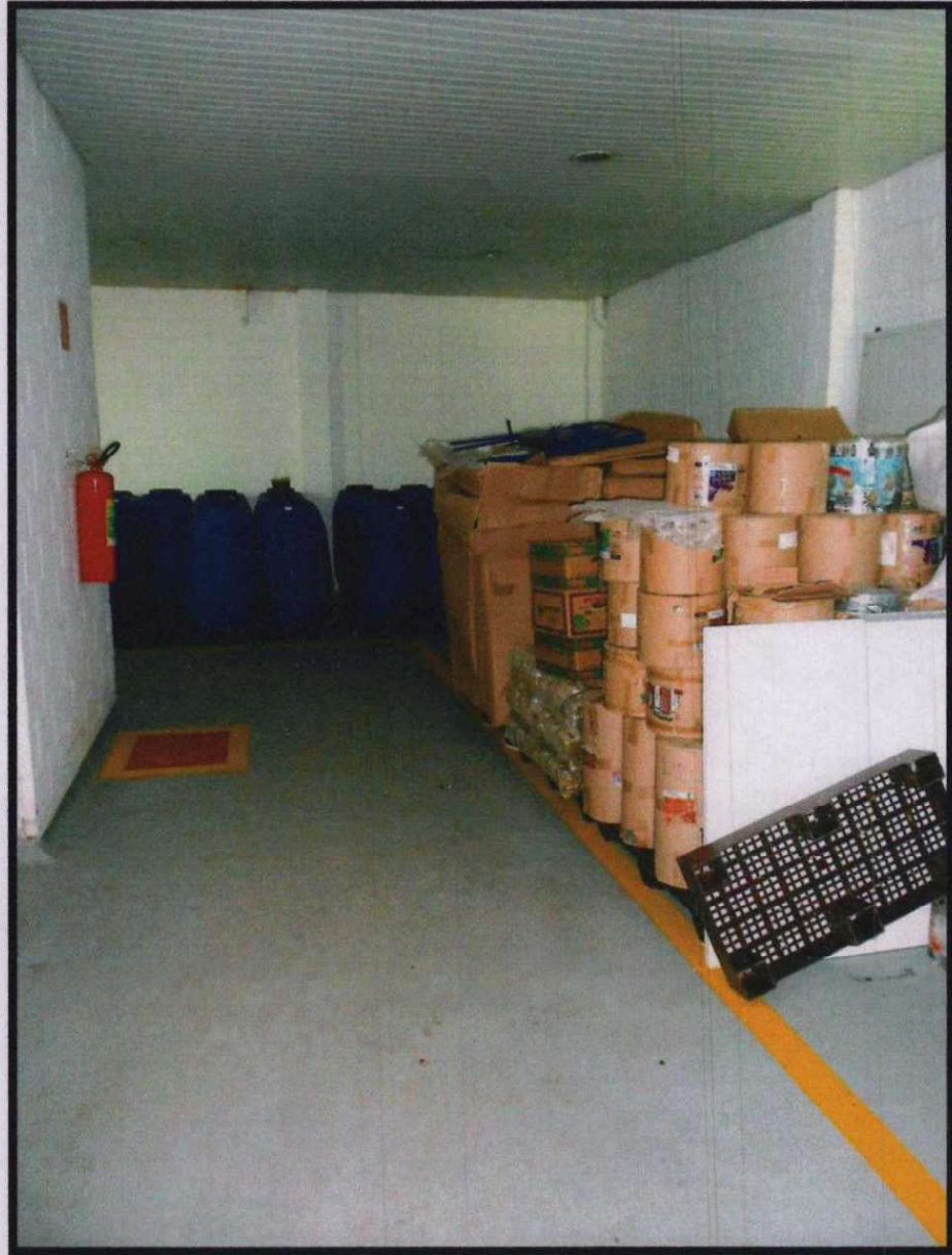
Vista do interior do galpão
