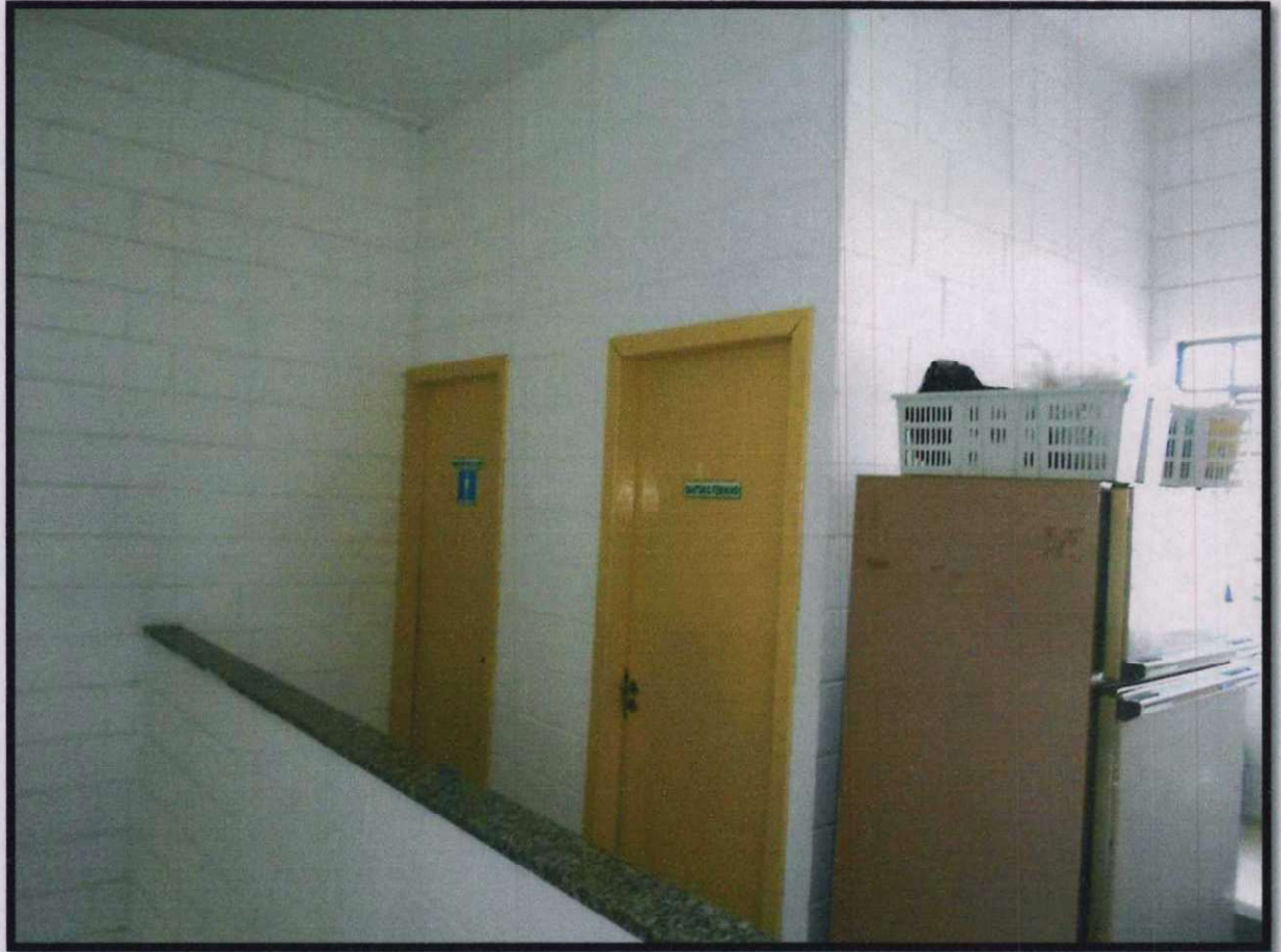
Vista dos sanitários (idênticos nos dois pavimentos)
