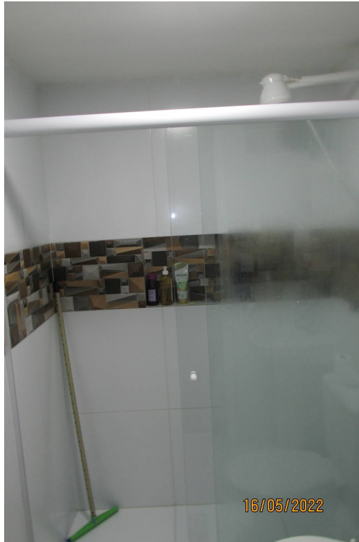
Foto 32) Detalhe da área de banho, tendo paredes revestidas por azulejos, faixa cerâmica decorativa e fechamento em vidro temperado e alumínio.
