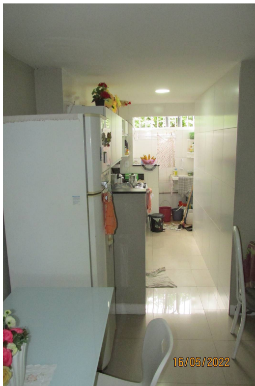
Foto 12) Vista da sala do apartamento frontal, acesso pelo nº 58. Observar piso em porcelanato, rodapé como o piso, paredes e teto a látex sobre massa corrida.
