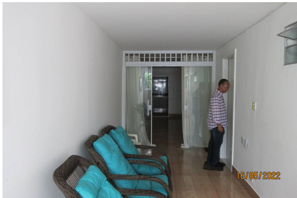
Foto 9) Vista da área de acesso às unidade sob nº 58. Observar piso e rodapé cerâmico, paredes e teto a látex sobre massa corrida. À direita temos a entrada do apartamento frontal e, a frente, o início do apartamento de fundos.
