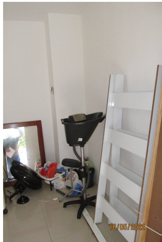
Foto 39) Vista de dependência existente próximo à porta de entrada e lateralmente ao acesso secundário ao salão. Observar acabamento de piso, paredes e teto.
