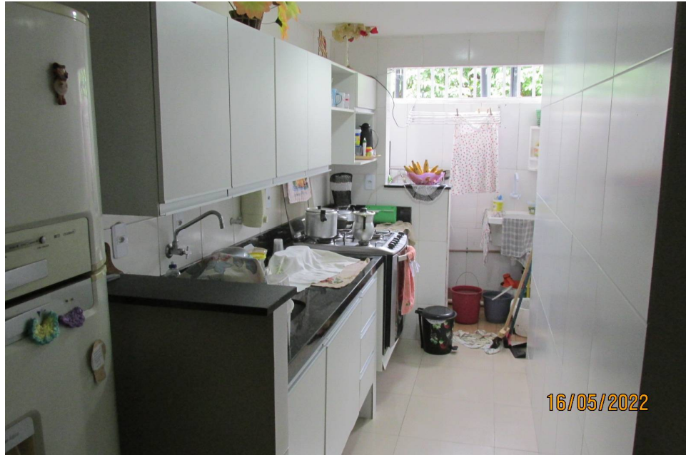
Foto 14) Vista da cozinha. Observar pia com tampo em granito, paredes revestidas por azulejos na cor branca e vão de ventilação e iluminação sem vidro, apenas com gradil.
