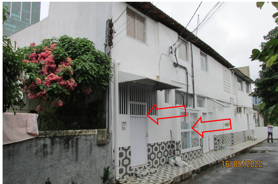
Foto 5) Vista da elevação do imóvel objeto. Em primeiro plano a porta de acesso às unidades sob nº 58; após, nicho dos medidores de energia. Observar fachada simples em massa única.
