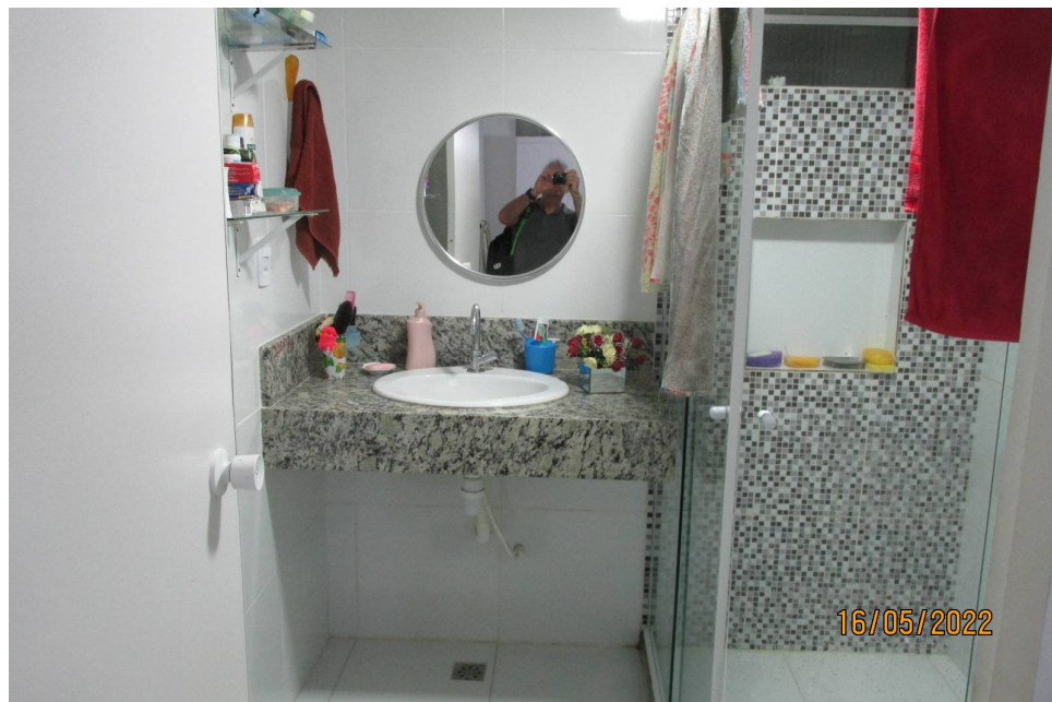
Foto 17) Vista do banheiro do apartamento frontal. Observar piso cerâmico, paredes e pia lavatório com tampo em granito e cuba em louça de embutir.
