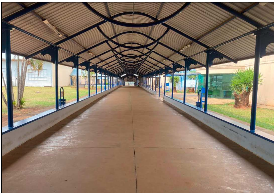
(passarela coberta com estrutura metálica com acessos aos blocos, às clínicas e à administração da faculdade)
