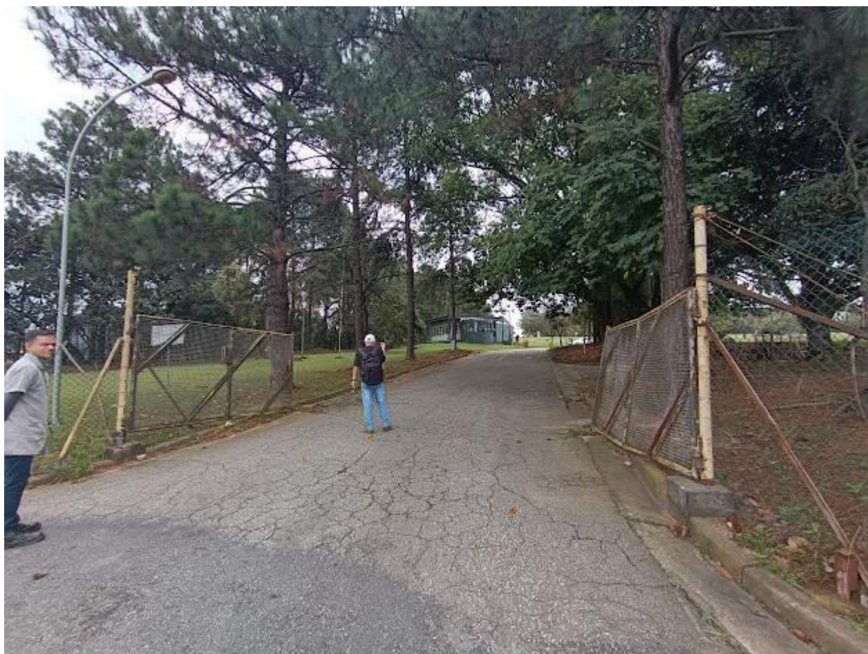
Foto 1: Entrada principal do imóvel avaliando (pela Rodovia Presidente Dutra, km 214 + 250m).
