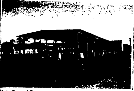
Vista Parcial Externa.
