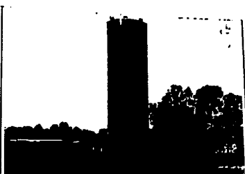
Caixa D'água Elevada.
