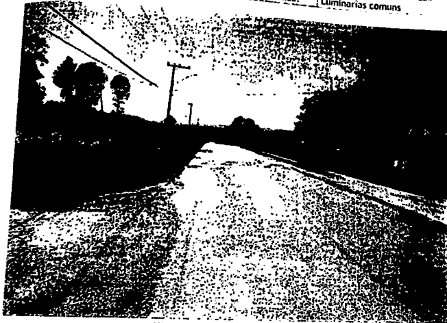
Vista geral da Av. Tranquillo Giannini.
