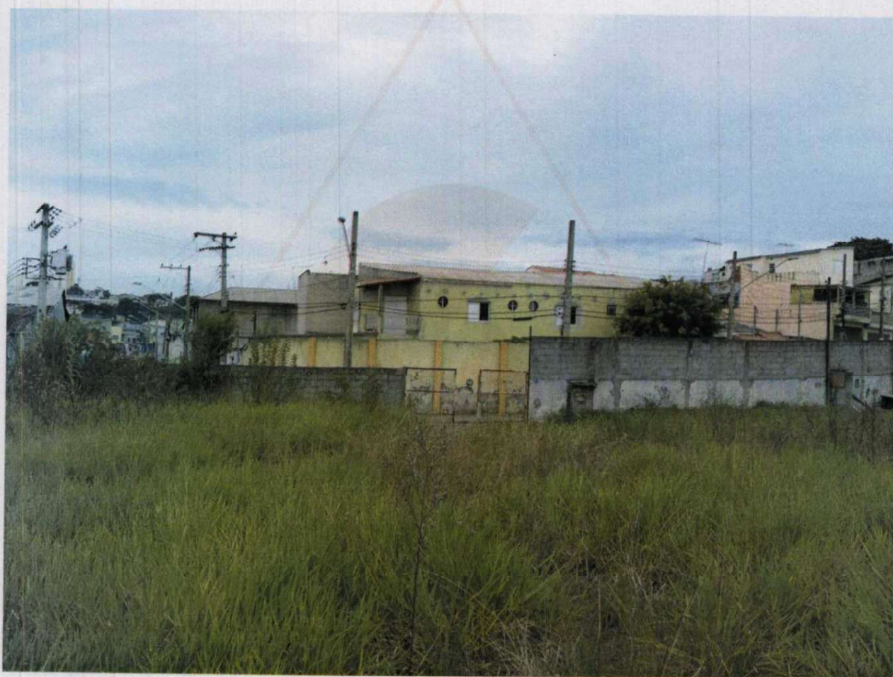
FOTO 12: VISTA PARCIAL DO IMÓVEL EM DIREÇÃO A TESTADA DO TERRENO.
