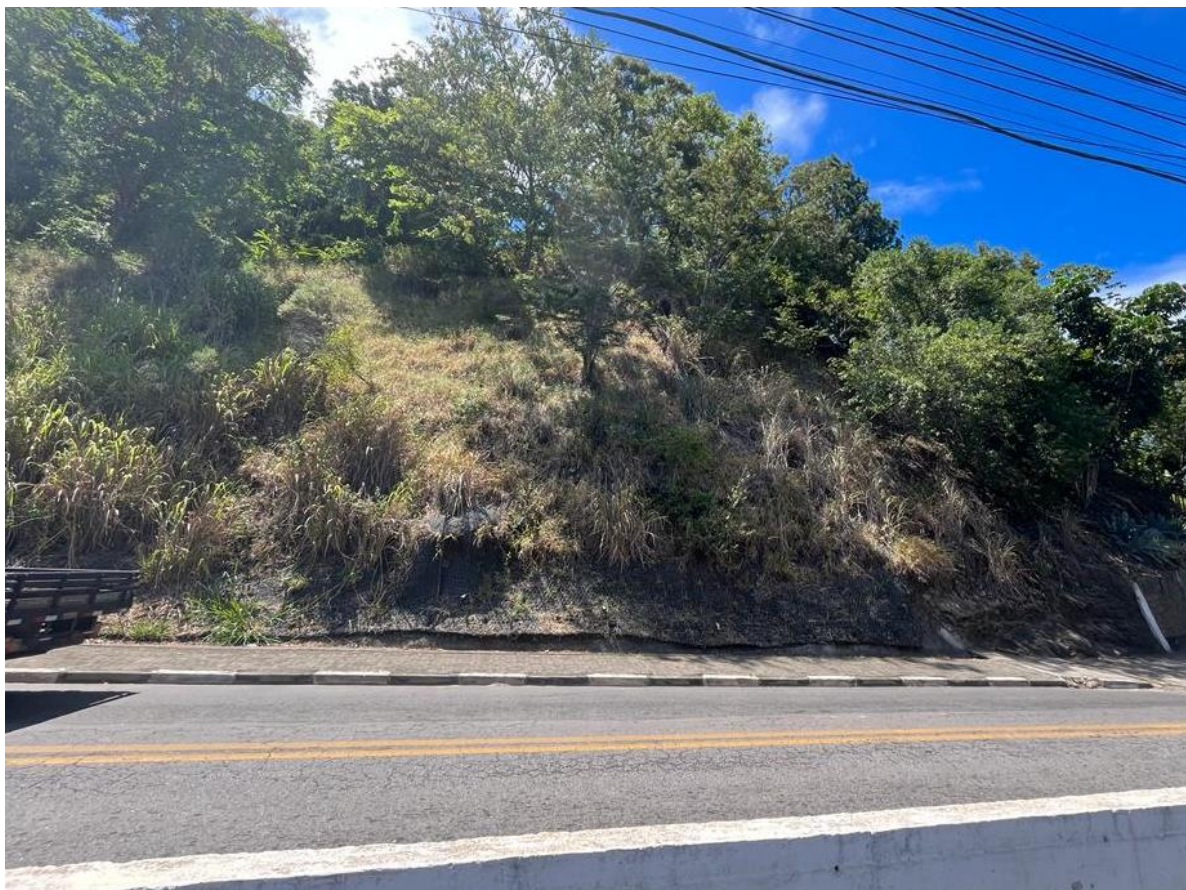
Figura 2 - Vista frontal do Imóvel Avaliando através da Avenida.
