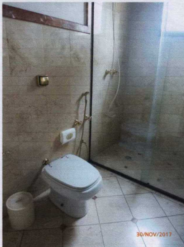
Foto nº. 23 – Vista parcial de um dos banheiros da suíte máster.
