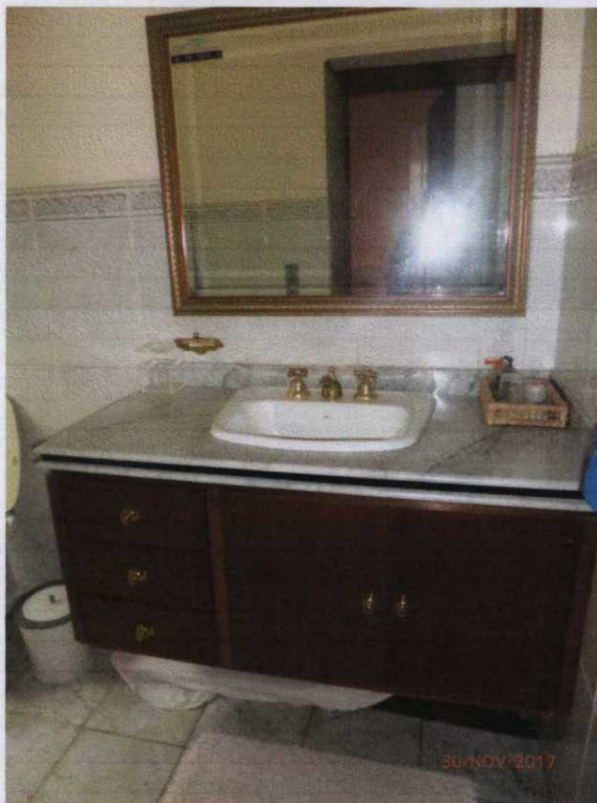
Foto nº. 13 – Vista parcial do banheiro da suíte.
