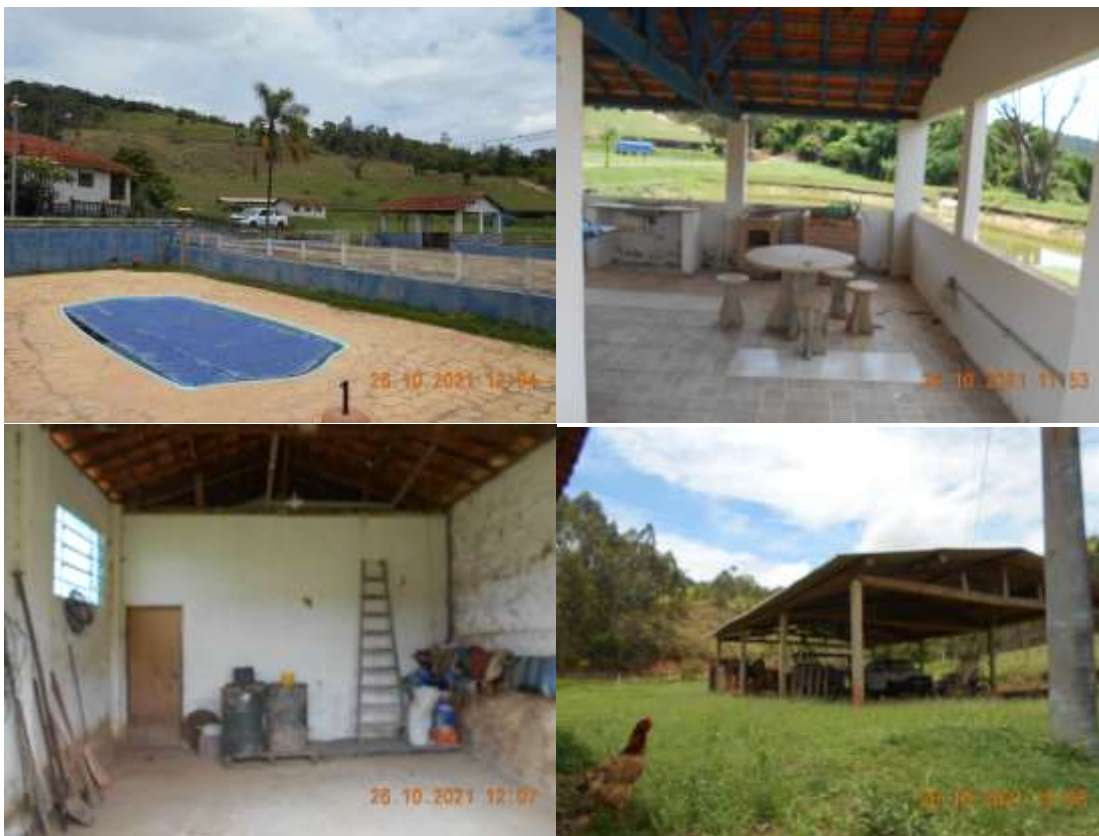
Fotos 24/27 - Vistas parciais da casa de colono, estabulo, galpão e rancho existentes no imóvel sub-judice
