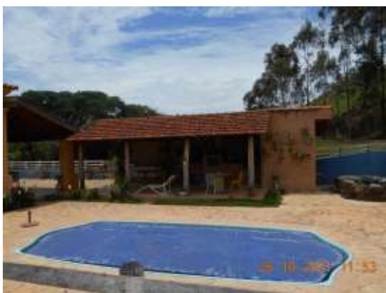
Fotos 09/23 - Vistas parciais externas e internas da casa sede com piscina e churrasqueira
