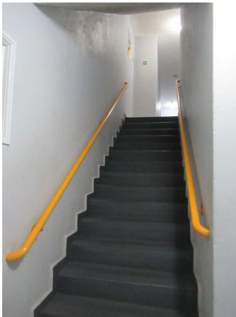
Foto nº. 13 – Vista da escada de acesso aos pavimento tipo.
