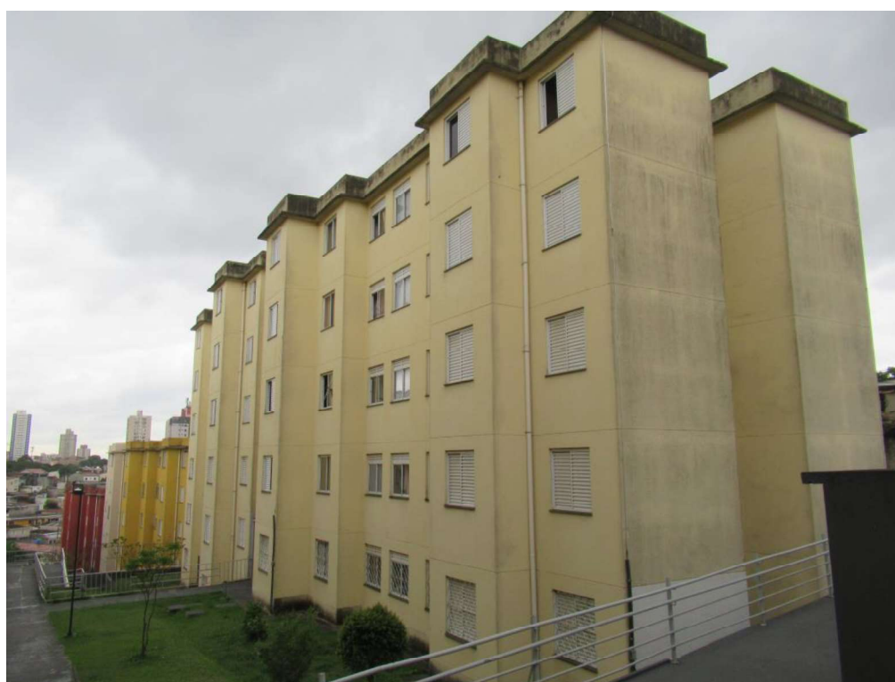
Foto nº. 11 – Vista da fachada do bloco 1, onde se localiza o imóvel avaliado no presente laudo.
