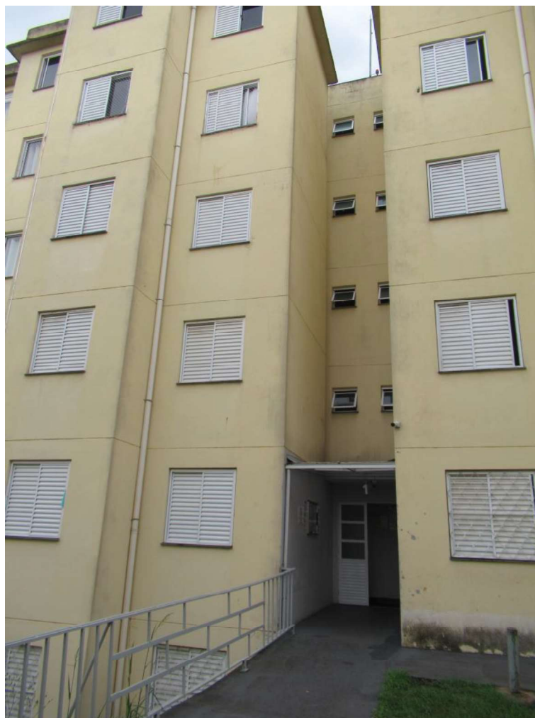
Foto nº. 12 – Vista da entrada do bloco 1.
