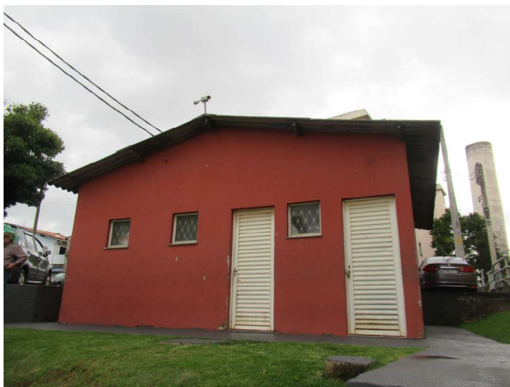
Foto nº. 9 – Vista do salão de jogos que por ocasião da vistoria estava em reforma.
