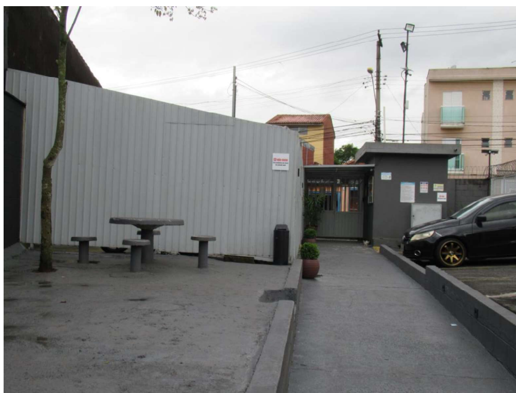
Foto n.º 5 – Vista da portaria.
