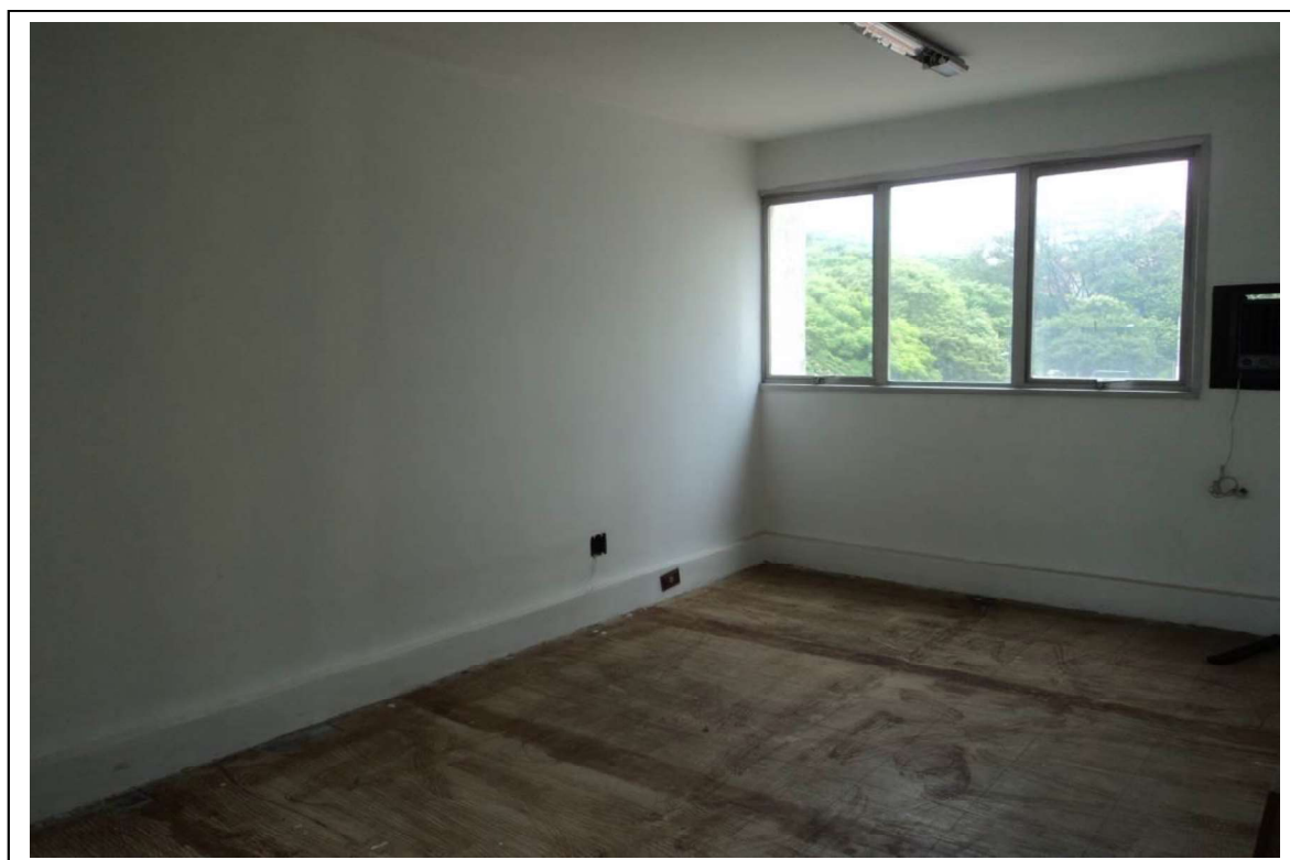
Foto 11: Outra vista interna da unidade nº 61 do Bloco H.
