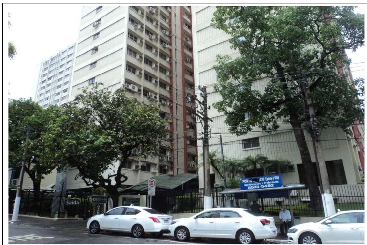
Foto 03: Vista do Conjunto Comercial Condomínio Ibirapuera Central Park.
