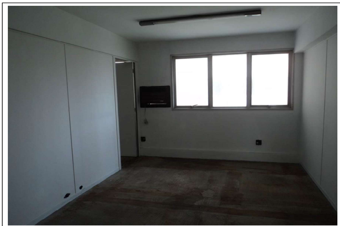
Foto 10: Outra vista interna da unidade nº 61 do Bloco H.
