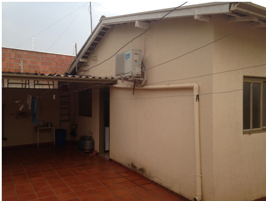
Foto 8 - Vista do imóvel avaliando
