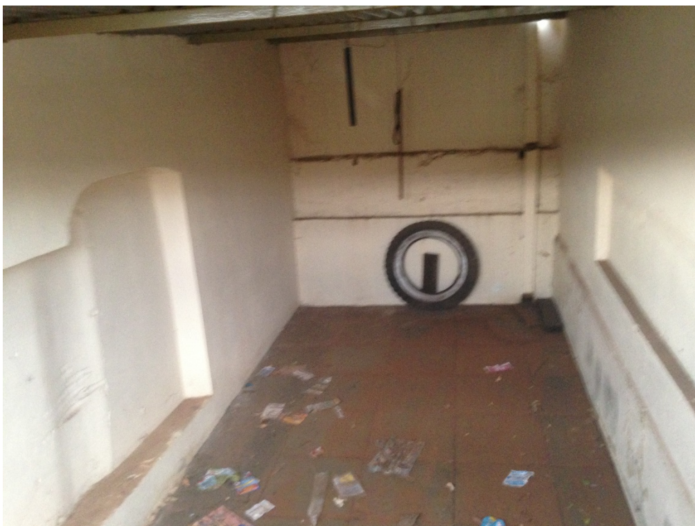
Foto 17 - Vista do depósito
