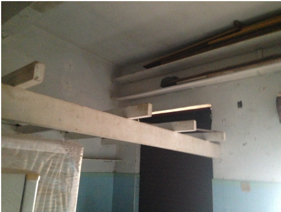
Foto 20 - Vista do teto/laje do salão comercial
