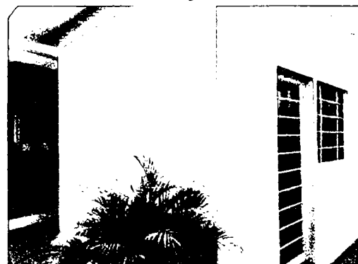
Vista da lateral da capela
