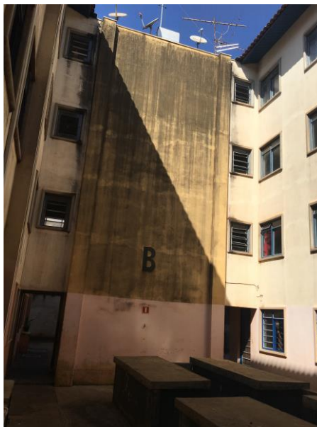
Foto 2 – Vista do Bloco B-1
