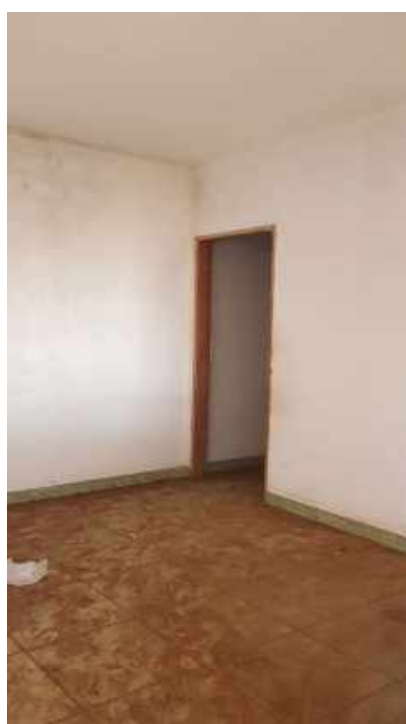
Fotografia 22: Vista do interior do imóvel avaliando – Área superior - Cozinha.
