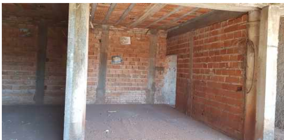
Fotografia 12: Vista do interior do imóvel avaliando – Área externa.
