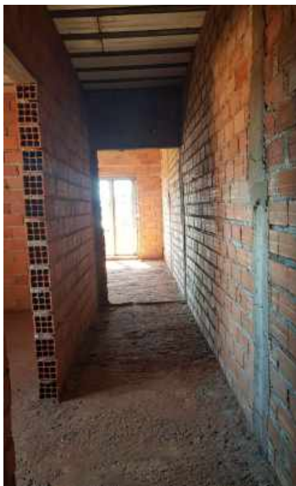
Fotografia 29: Vista do interior do imóvel avaliando – Área superior - Dormitório.
