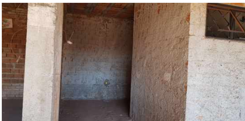
Fotografia 13: Vista do interior do imóvel avaliando – Área externa.
