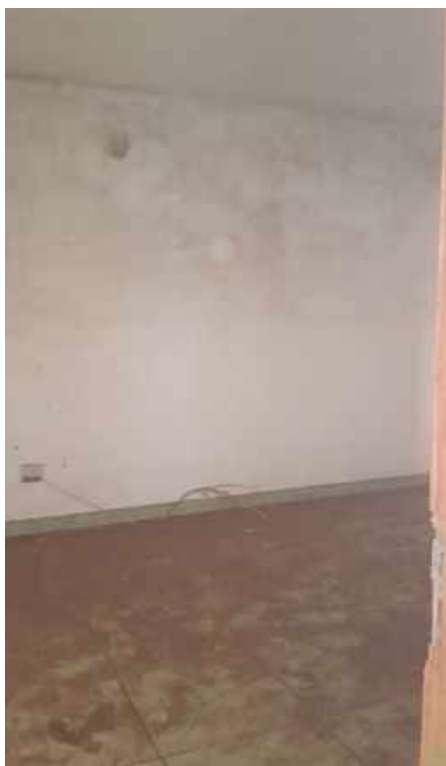
Fotografia 26: Vista do interior do imóvel avaliando – Área superior - Segundo dormitório.
