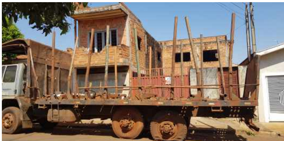
Fotografia 01: Vista do imóvel avaliando – Fachada.
