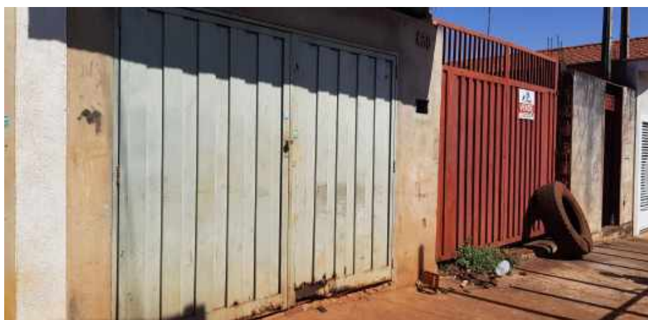
Fotografia 07: Vista dos portões de acesso ao imóvel avaliando.
