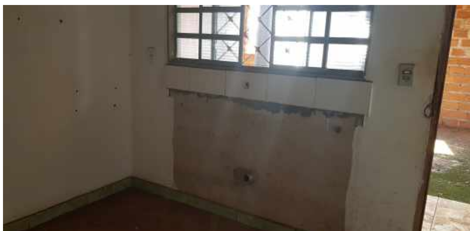
Fotografia 23: Vista do interior do imóvel avaliando – Área superior - Cozinha.
