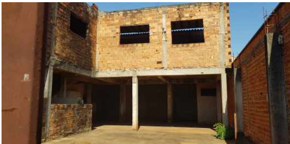
Fotografia 08: Vista do interior do imóvel avaliando – Área externa.
