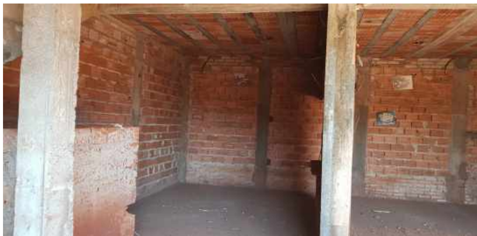
Fotografia 11: Vista do interior do imóvel avaliando – Área externa.
