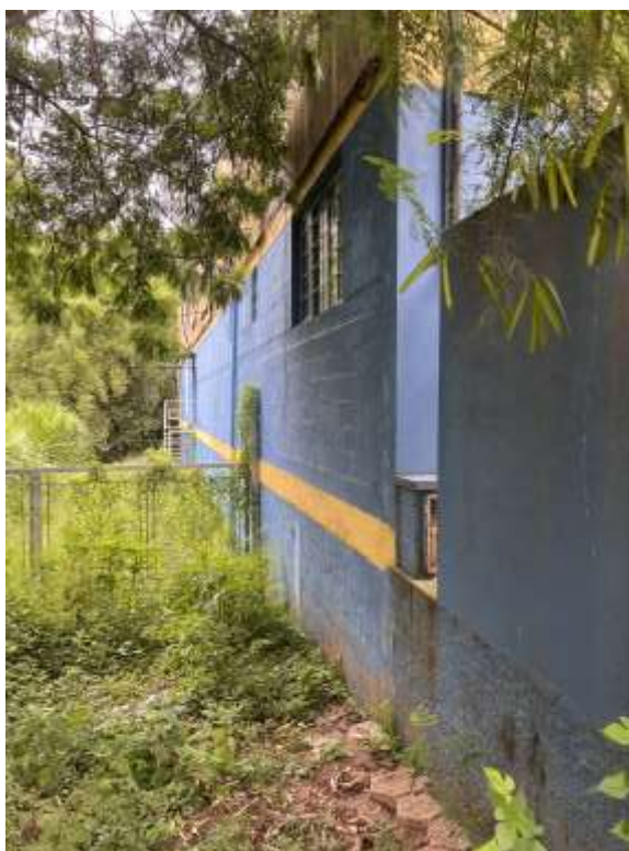
Fig. 8 – Lateral do terreno, lado esquerdo, onde pode-se observar escada que desce para o porão.
