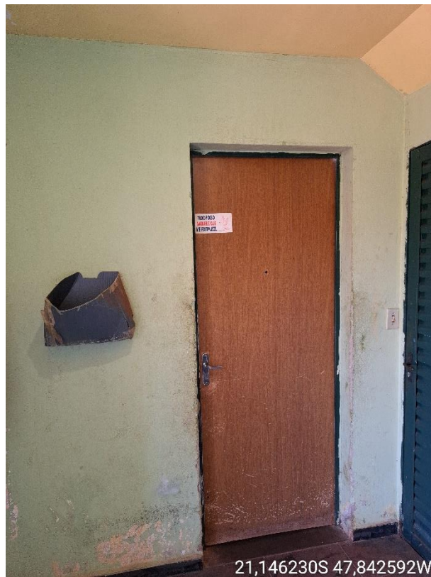
Foto 6 - Vista da porta de entrada do apartamento objeto
