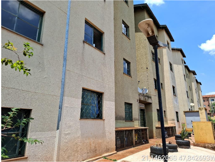
Foto 5 - Vista do bloco 03
