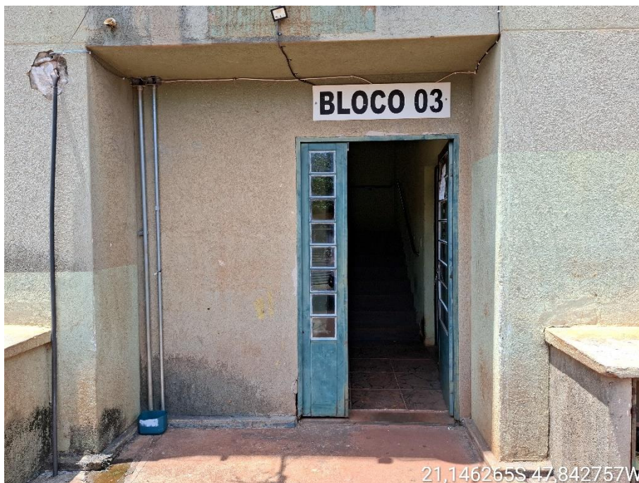
Foto 4 - Vista da entrada do Bloco 03
