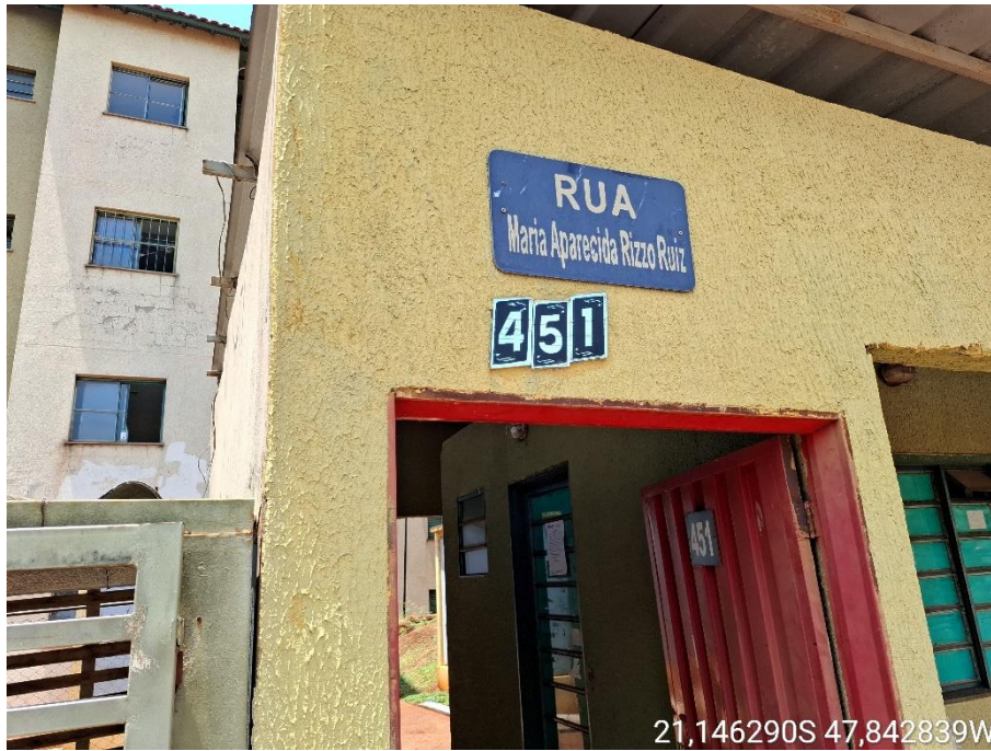
Foto 3 - Vista da identificação do condomínio
