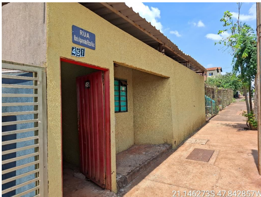
Foto 2 - Vista da fachada do edifício/condomínio
