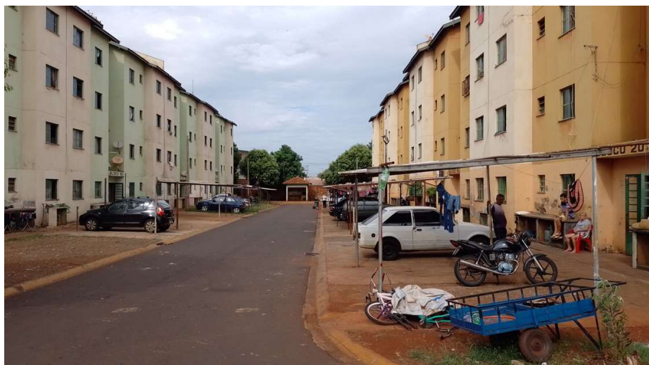
Visao geral das vias internas do Condomínio Residencial.
