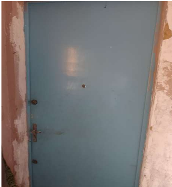
Porta de acesso ao apartamento avaliando porta e janelas fechadas.
