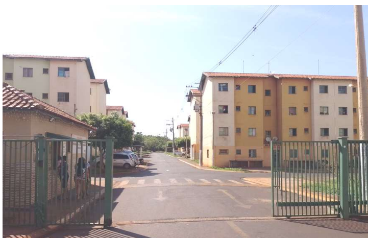
Portaria do condominio Aragão II – Sertãozinho/SP.
