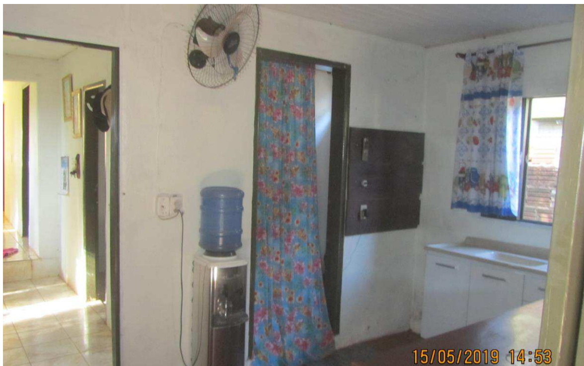
FOTO 19> Detalhe interno, cozinha, forro PVC.
