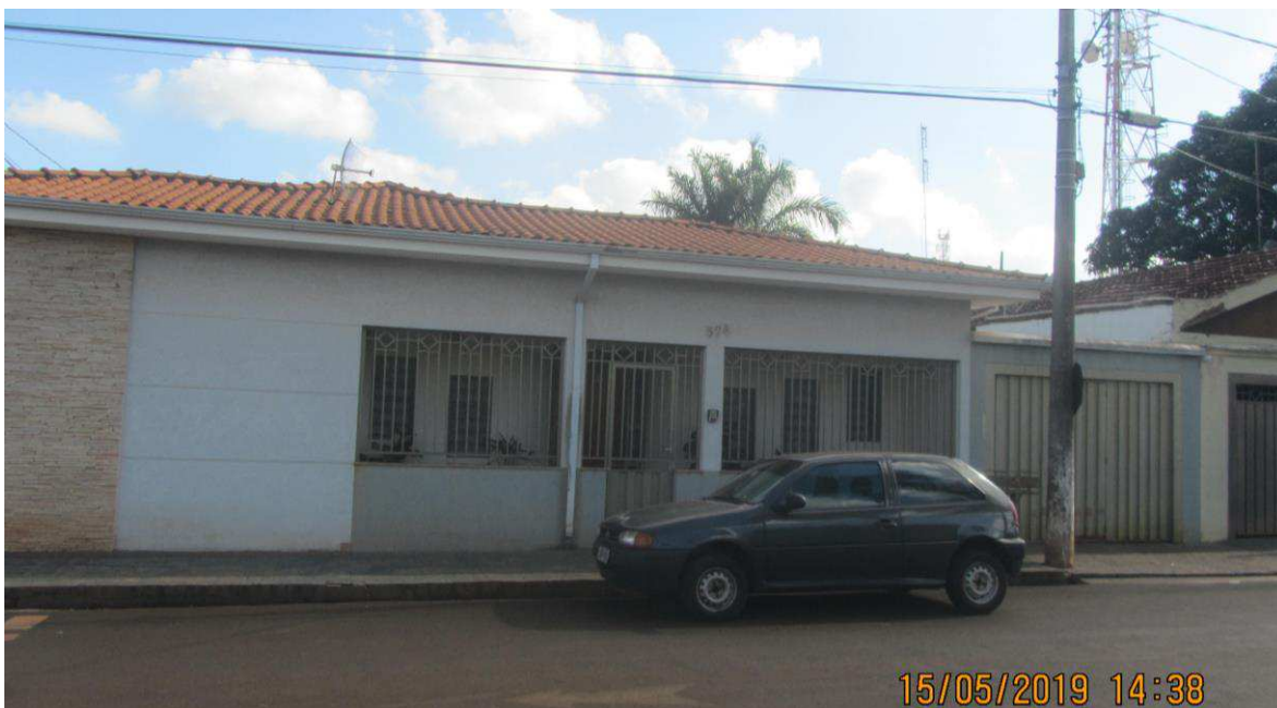
Foto 02 ► Detalhe da fachada do imóvel visto da Rua Jeronimo Vieira.
