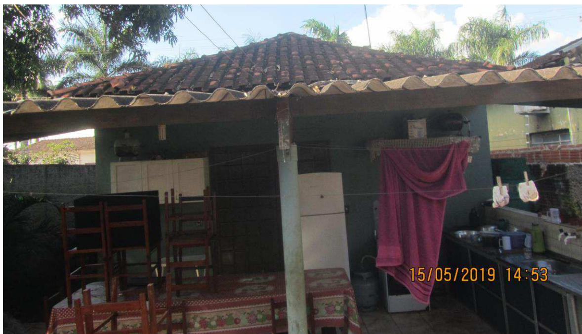
FOTO 04> Detalhe externo, fundos.
