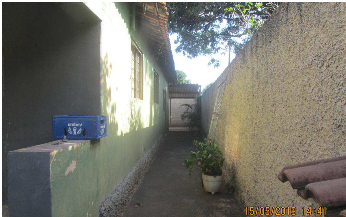
FOTO 15> Detalhe externo do imóvel 02, acesso aos fundos.
