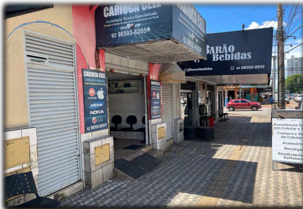
Foto 04 – Vista do imóvel Matrícula nº 1.757 (Setor Nova Vila)
