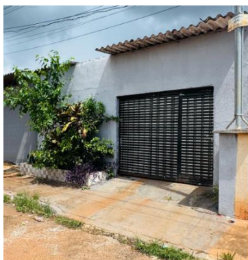
Fotos do Imóvel no dia 09/04/2025
