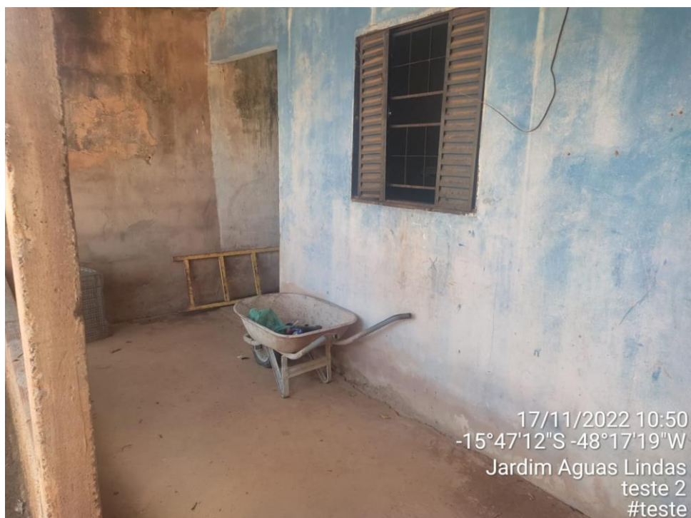
Figura 18- imóvel avaliado fundos
