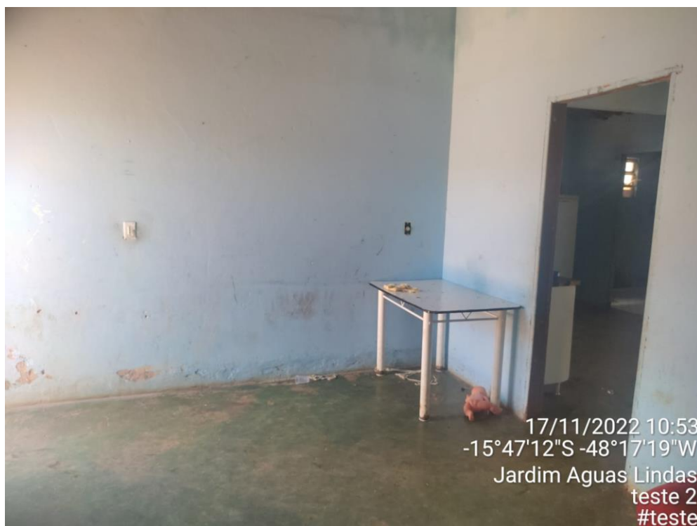
Figura 8- imóvel avaliado frente
