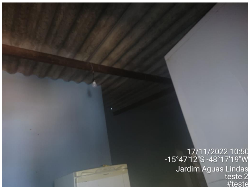
Figura 20- imóvel avaliado fundos
