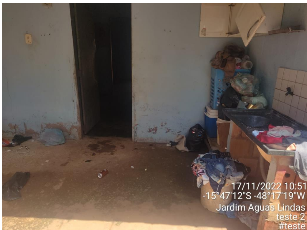
Figura 2- imóvel avaliado frente
