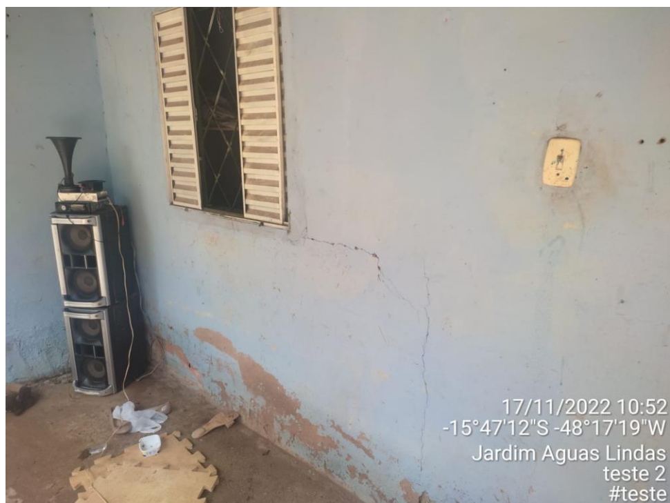
Figura 1- imóvel avaliado frente
