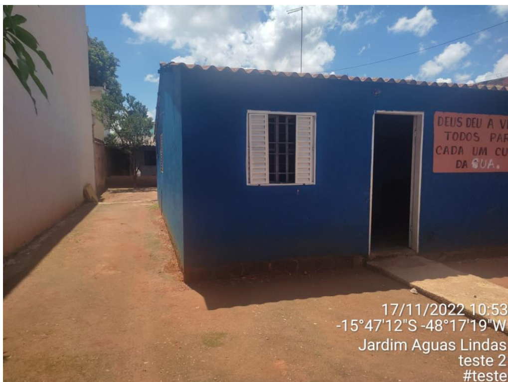
Figura 11- imóvel avaliado frente
