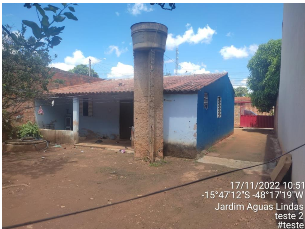
Figura 12- imóvel avaliado frente
