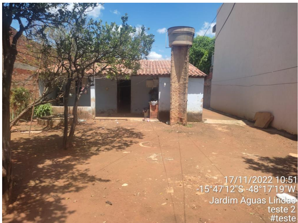
Figura 13- imóvel avaliado frente
