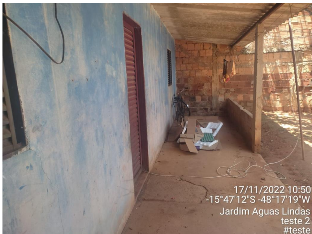
Figura 16- imóvel avaliado fundos
