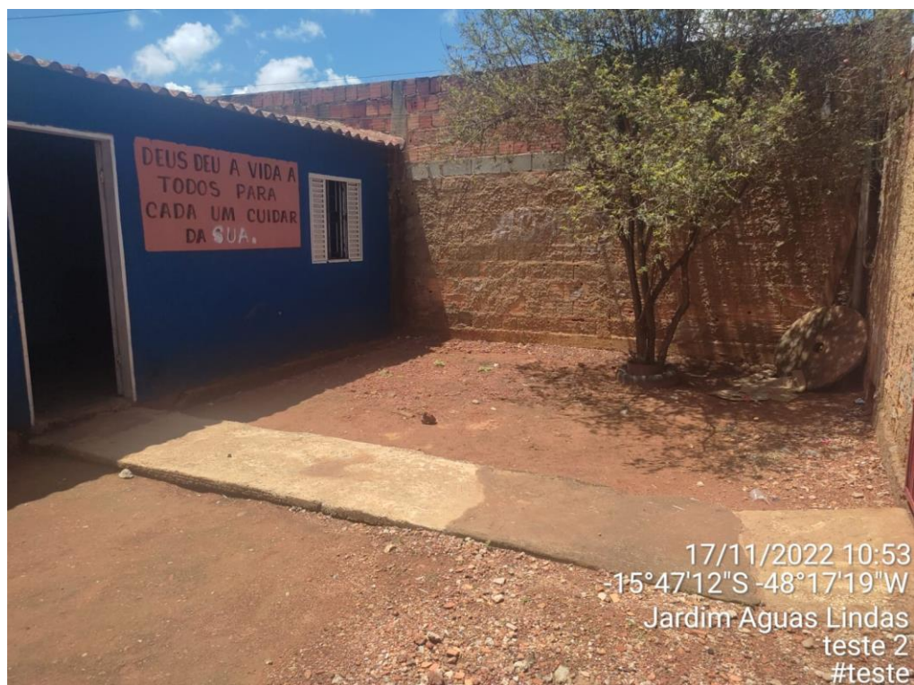
Figura 10- imóvel avaliado frente
