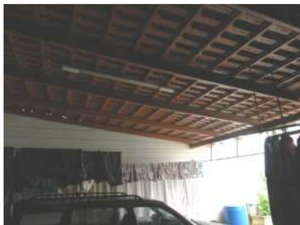
Foto 11: Estrutura metálica e telha cerâmica
