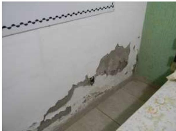
Foto 21 : Paredes com mofo e destacamento tinta
