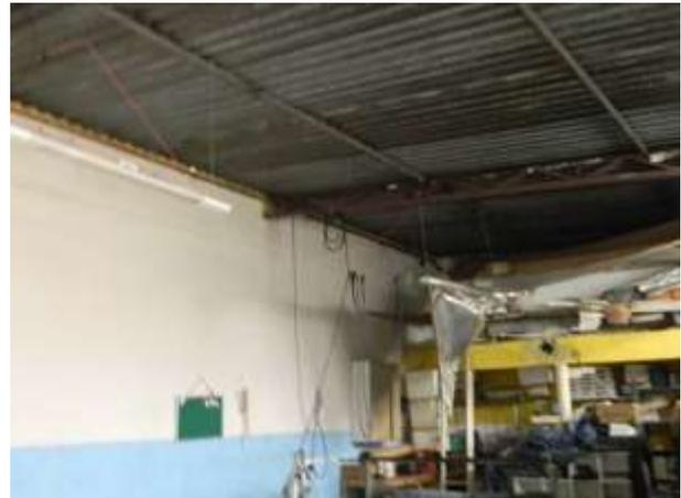
Foto 7: Estrutura Metálica e telha de zinco
