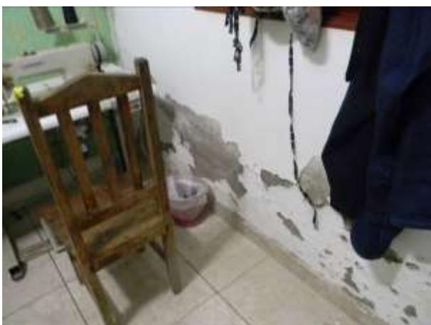
Foto 22 e 23 : Paredes com mofo e destacamento tinta
