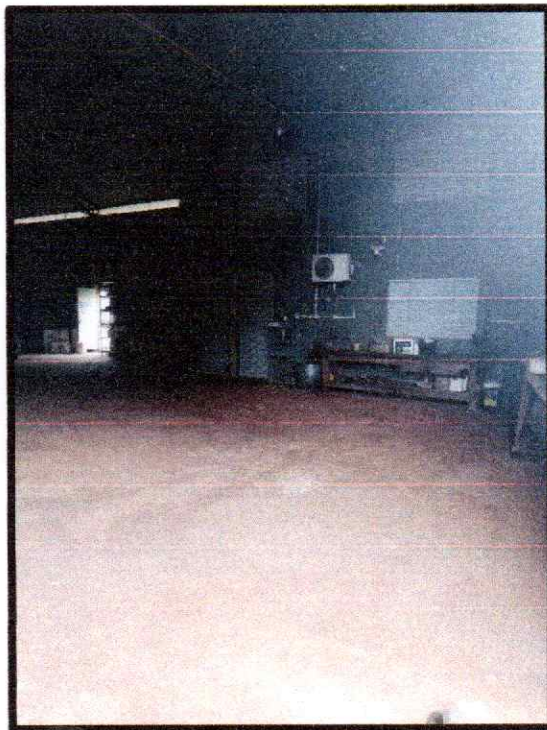
Foto 13 Lateral Direita - Parte Interna Galpão
