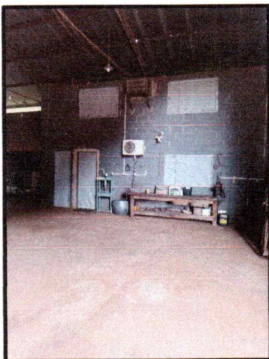
Foto 14 1ª Porta – Acesso ao Depósito 2ª Porta – Acesso ao Banheiro Galpão
