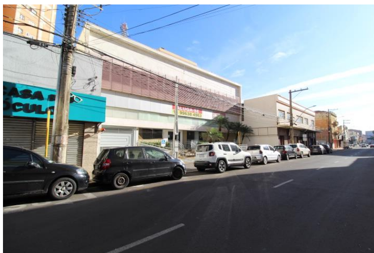
07- Vista lateral esquerda do Avaliando com logradouro
