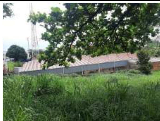
Foto 8: Vista da área
