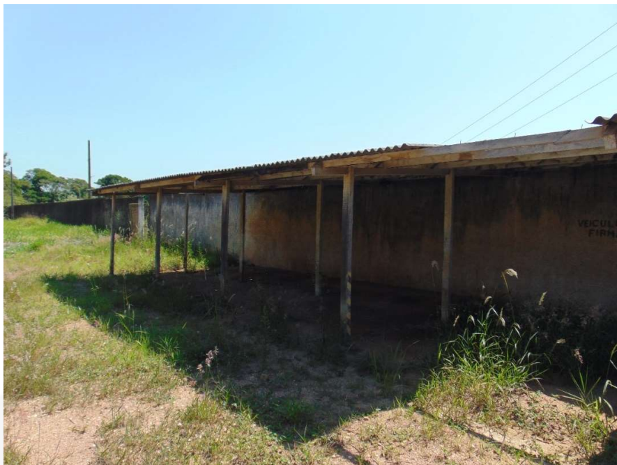
Figura 4.14 Edificação provisória de estacionamento
