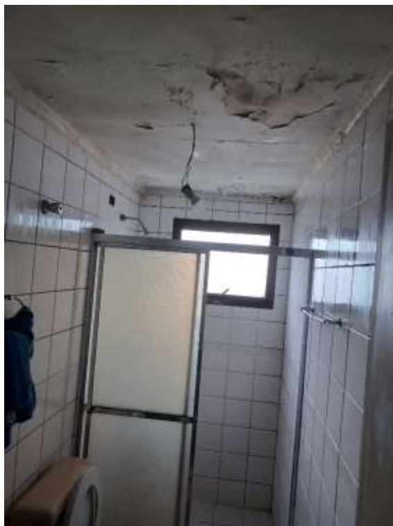
Foto 7: Banheiro 1ª suíte
