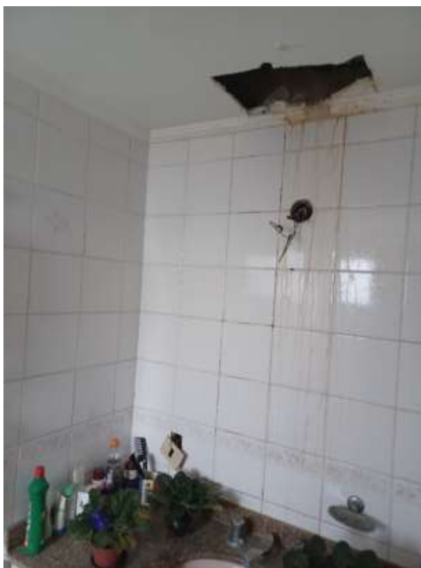
Foto 11: Banheiro 3ª suíte
