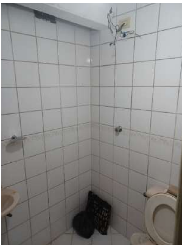
Foto 9: Banheiro 2ª suíte
