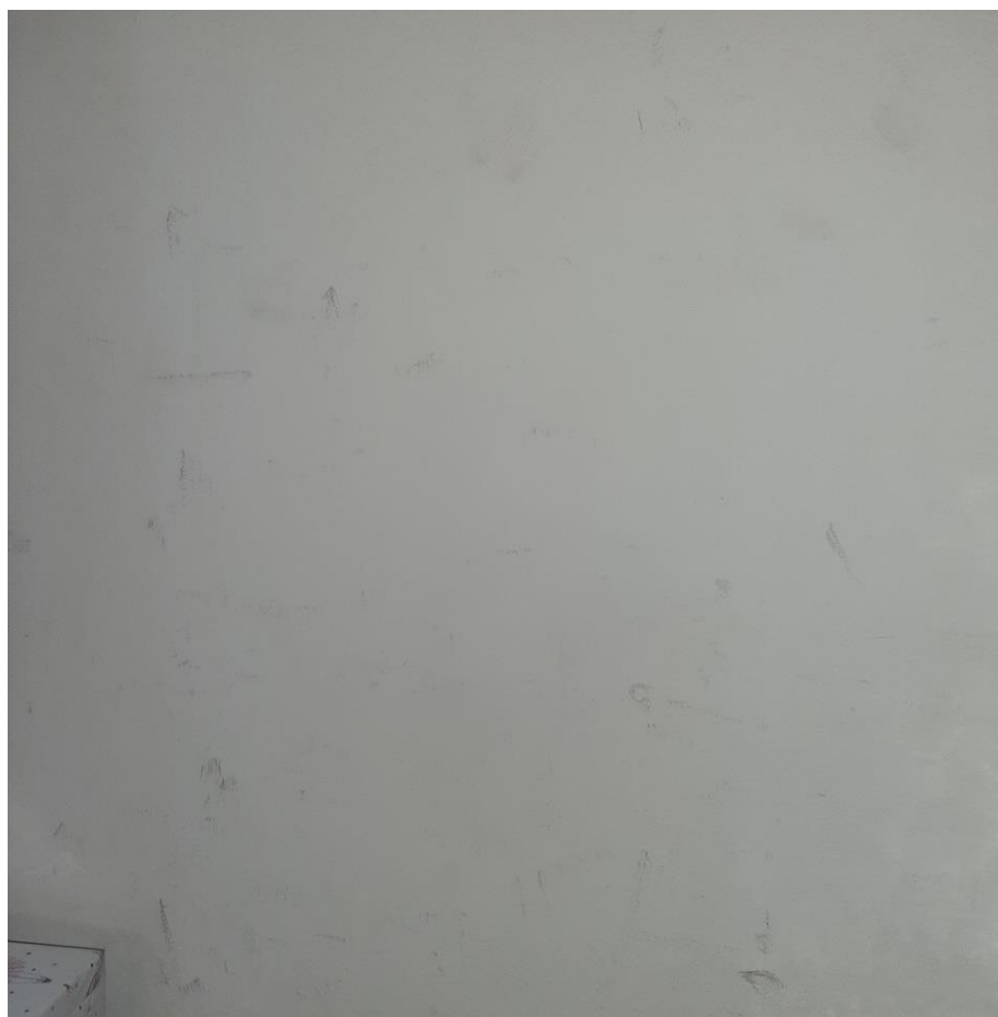
. Imagem 22: Detalhe da pintura de uma das paredes.
