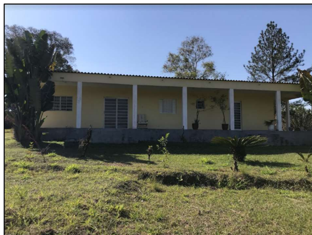
Vista edificação lateral
