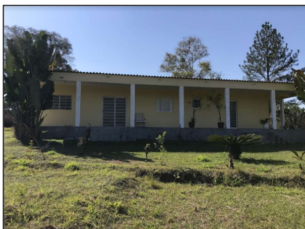
Vista do Imóvel Avaliando
