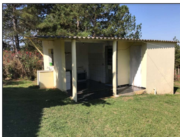
Edificação tipo edícula
