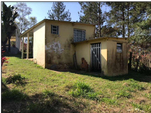
Edificação tipo edícula
