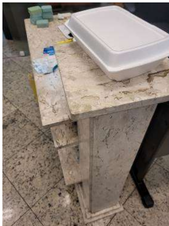
FOTOS Nº 09/10: Detalhe interno do imóvel avaliando.
