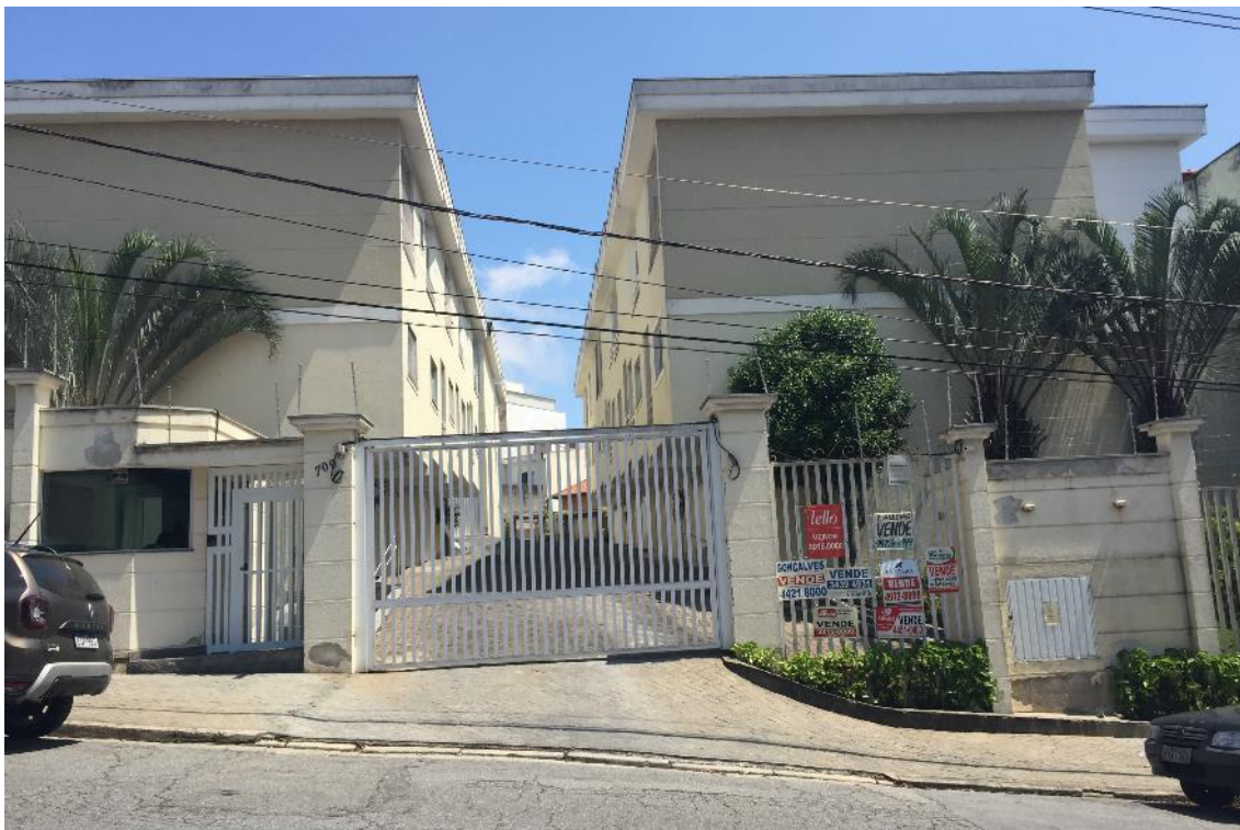
Foto 3 – Vista da fachada do imóvel avaliando
