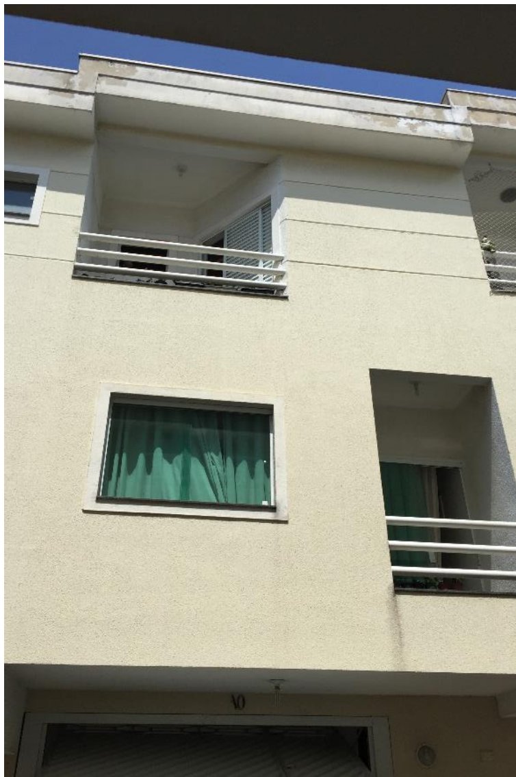
Foto 5 – Vista da fachada da casa de nº 10, observando-se os demais pavimentos
