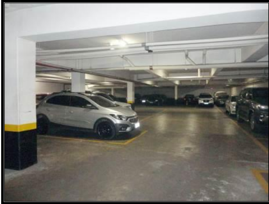
Vista da geral da garagem.
