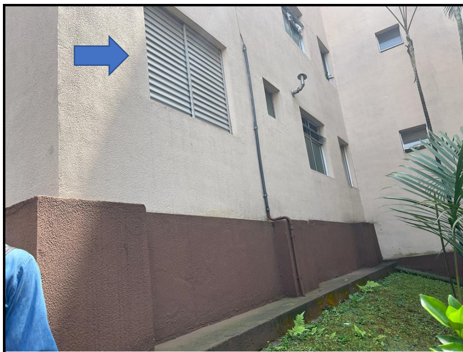
Foto 16: Edifício Olinda - Apartamento 11
