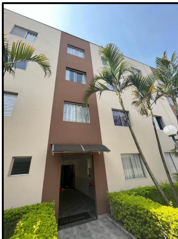
Foto 13: Bloco A-1, Edifício Olinda
