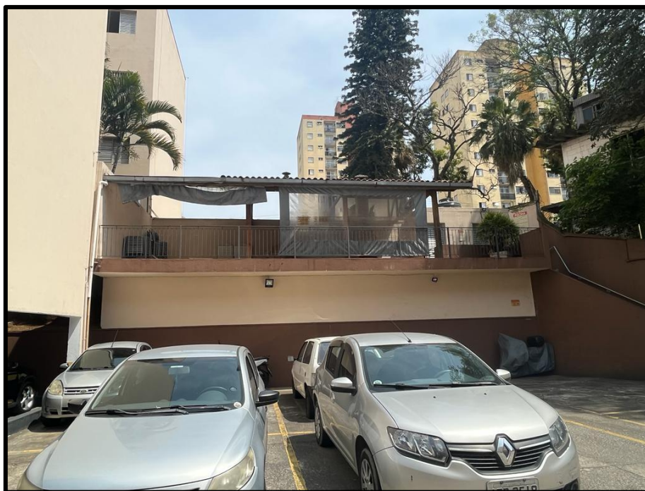
Foto 11: Garagem descoberta, churrasqueira e acesso para piscina
