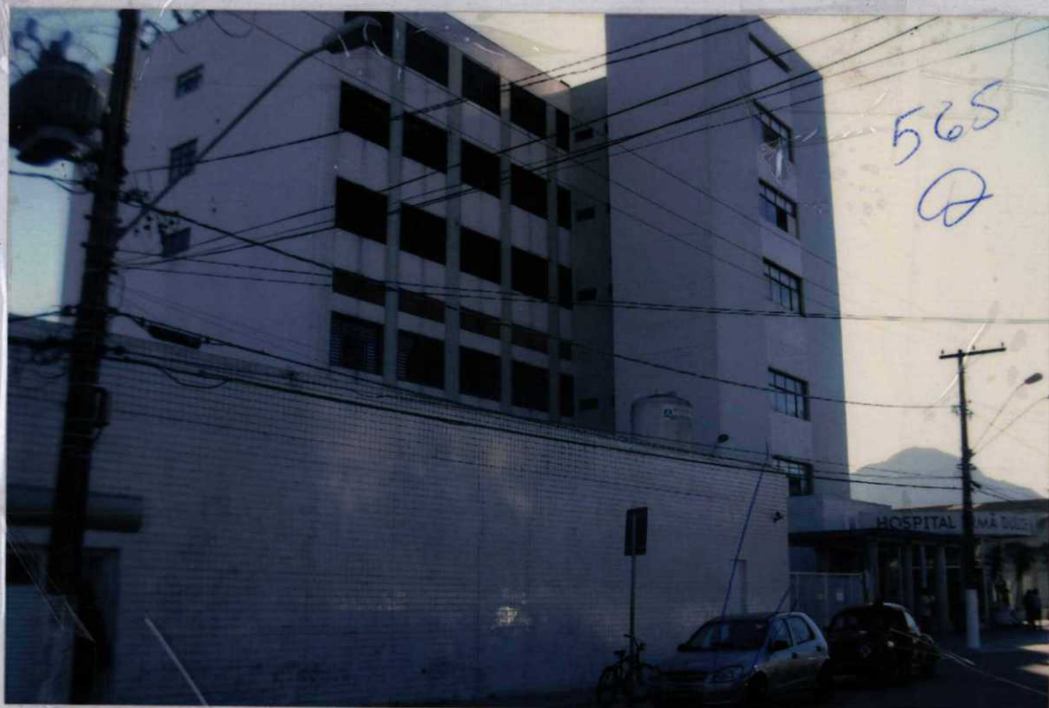
Foto nº 2 – outra vista da fachada
