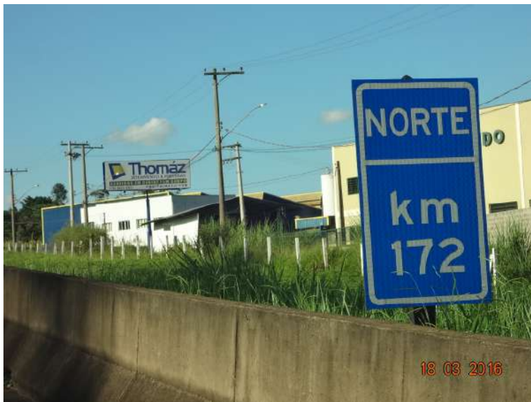
Vista da rodovia SP 330
