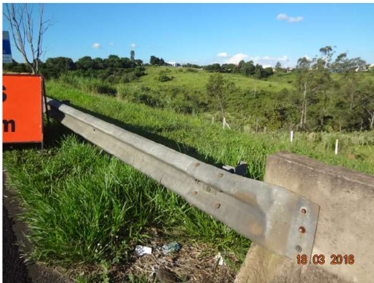
Vista da rodovia SP 330
