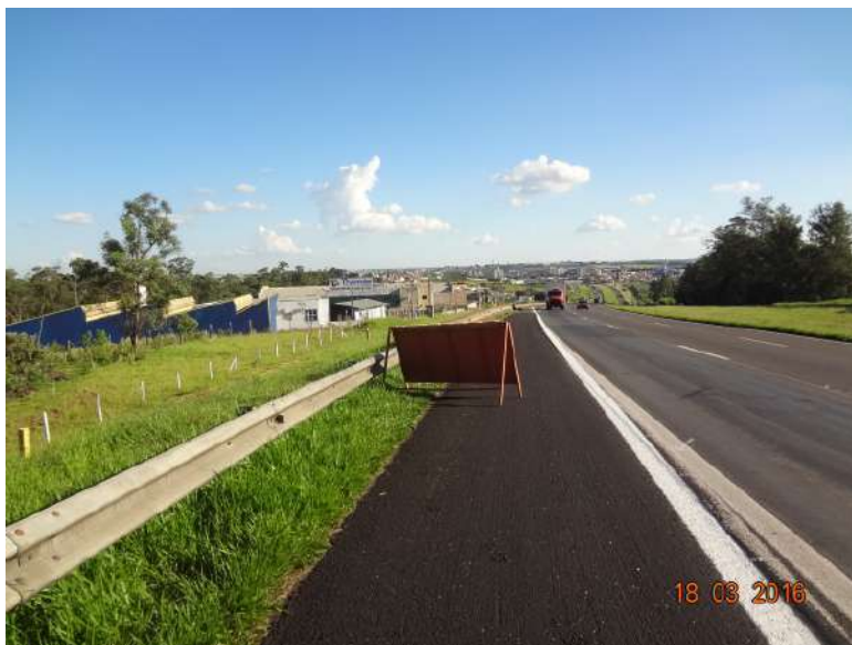
Vista da rodovia SP 330
