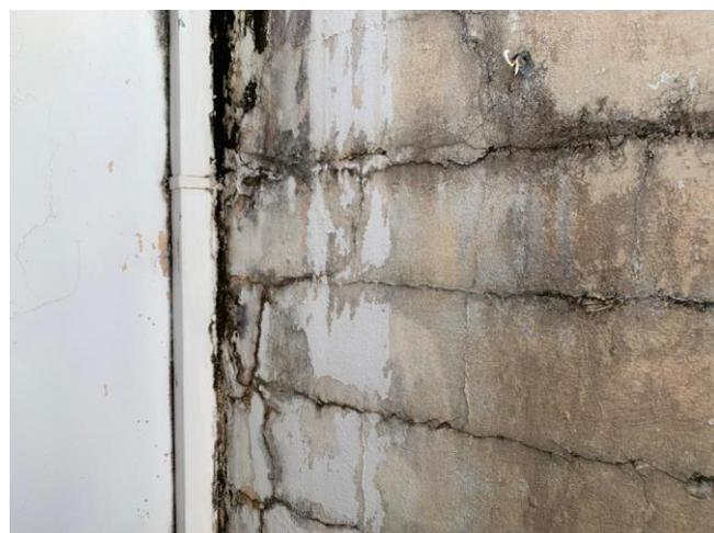
Foto 12. Rachaduras no muro lateral
