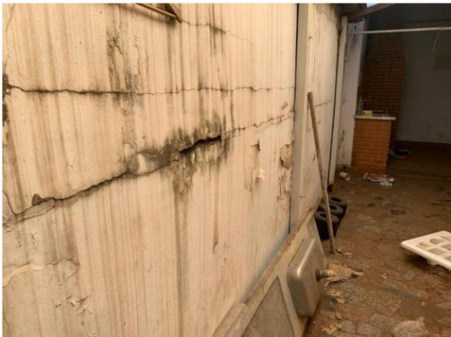
Foto 15. Rachaduras no muro
