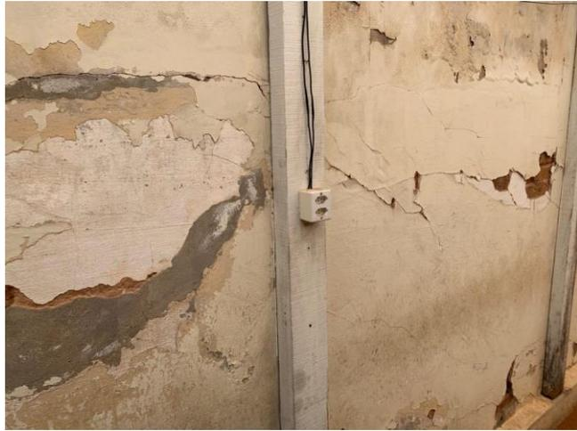
Foto 14. 2 Rachaduras no muro lateral
