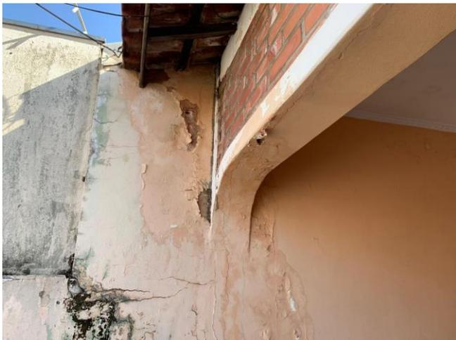
Foto 3. Rachaduras/infiltrações
