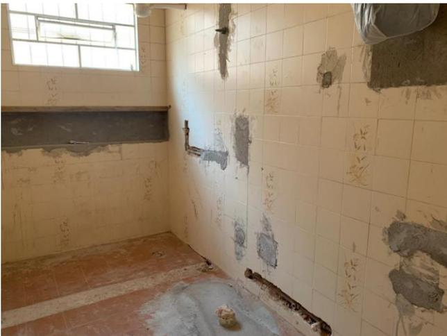
Foto 9. O imóvel não dispõe de hidráulica, visto que o encanamento foi retirado devido à vazamentos
