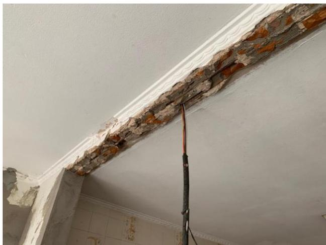
Foto 5. Armadura da viga está exposta
