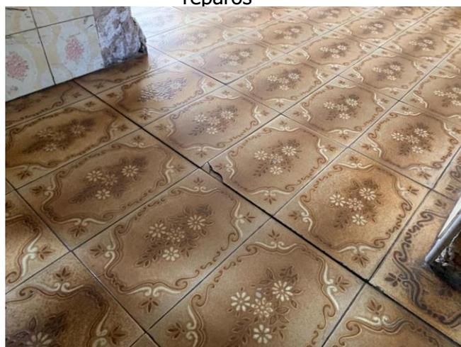
Foto 11. Rachaduras em pisos e revestimento
