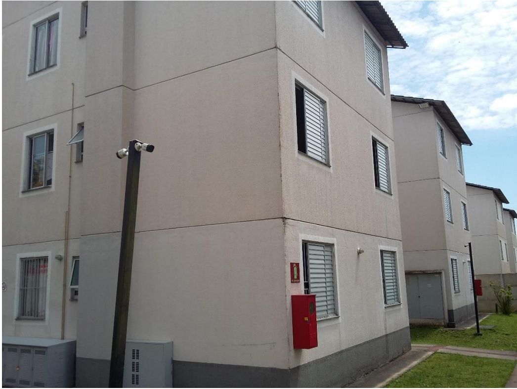
Figura 7 – Vista dos blocos.
