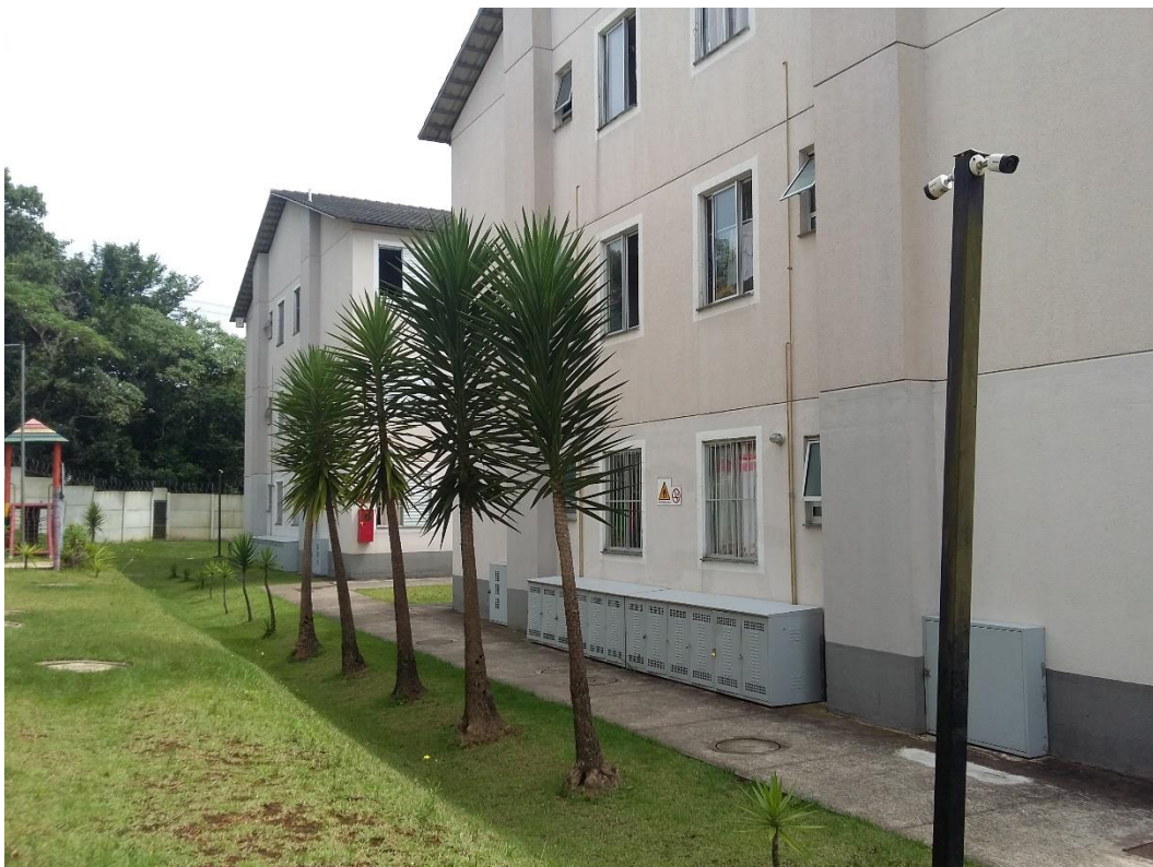
Figura 8 – Bloco do apartamento avaliando.
