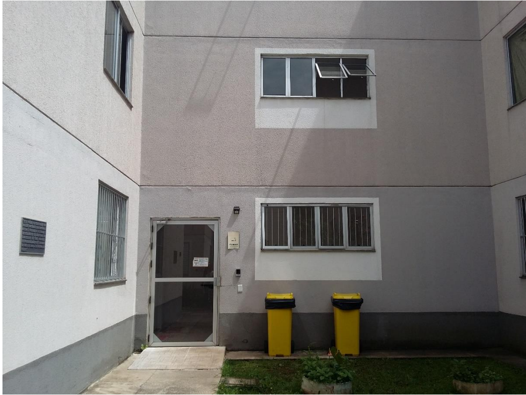
Figura 9 – Acesso ao bloco do imóvel avaliando.
