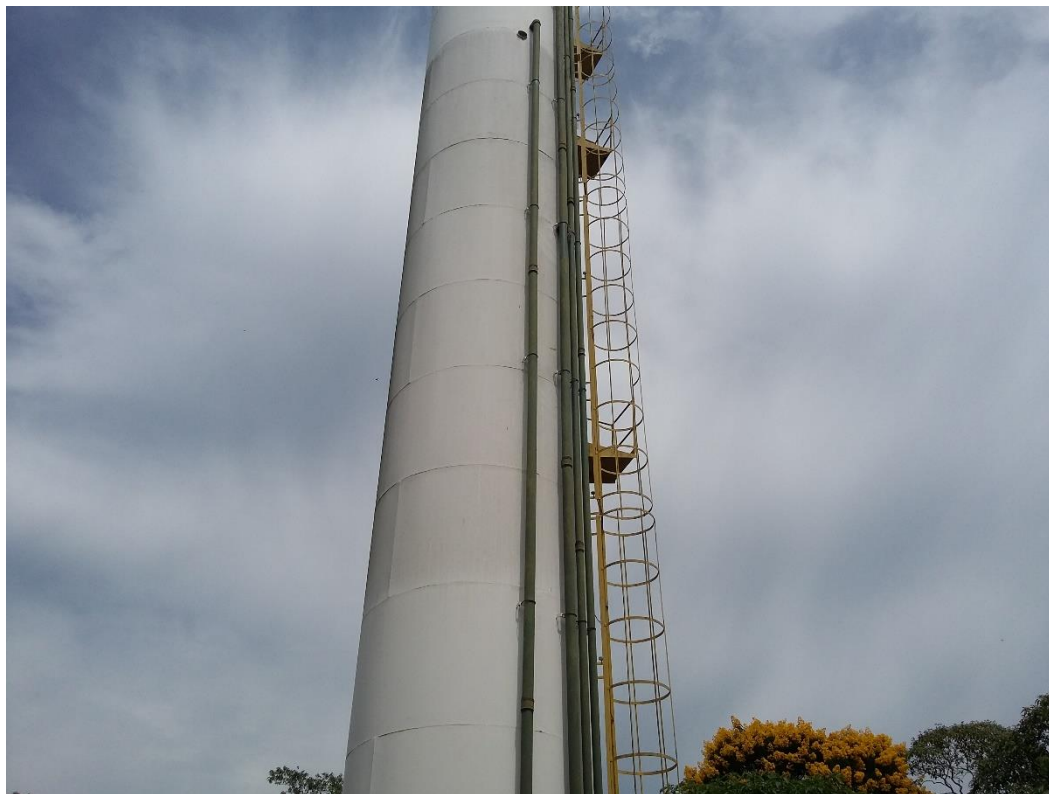
Figura 25 – Torre de caixa d'água do condomínio.
