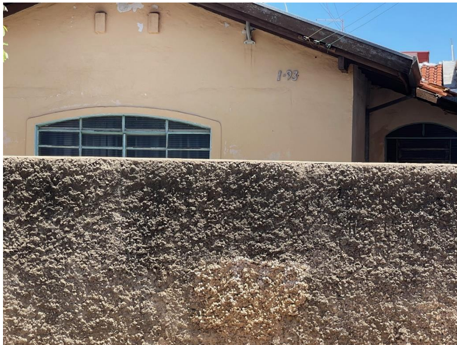
Foto 01. Elevação principal do imóvel. Rua São João, 1-93
