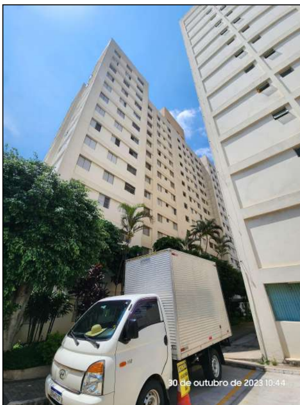
IMAGEM 12: Vista do Bloco C.
