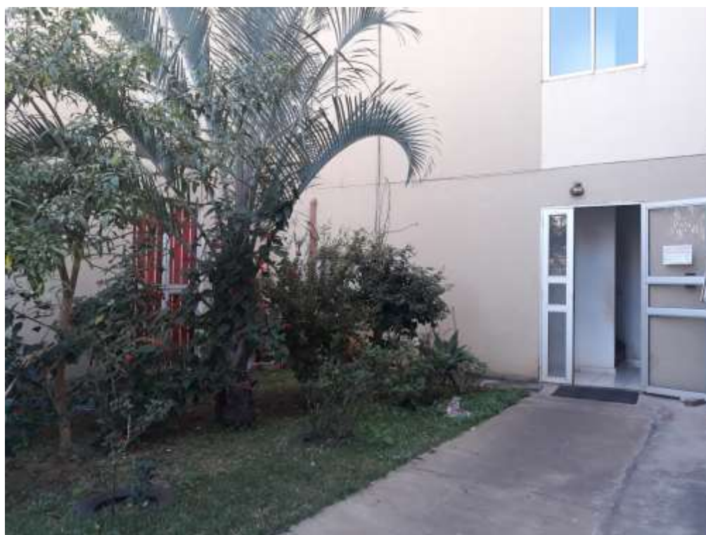
6 - Entrada no Bloco 04
