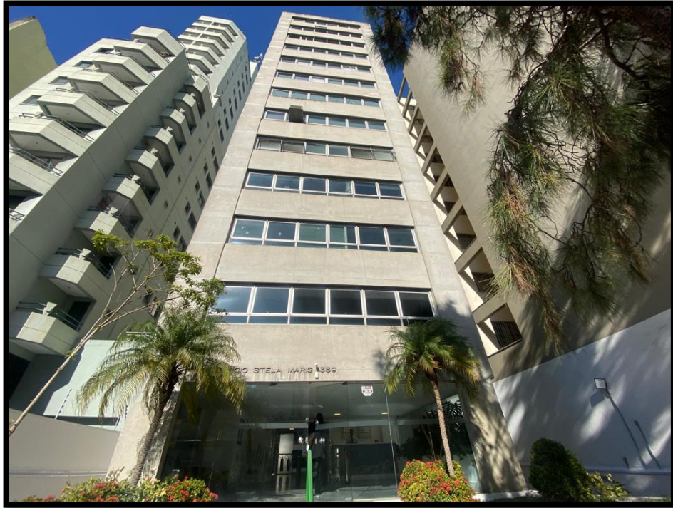
Imagem 2- Fachada do Edifício
