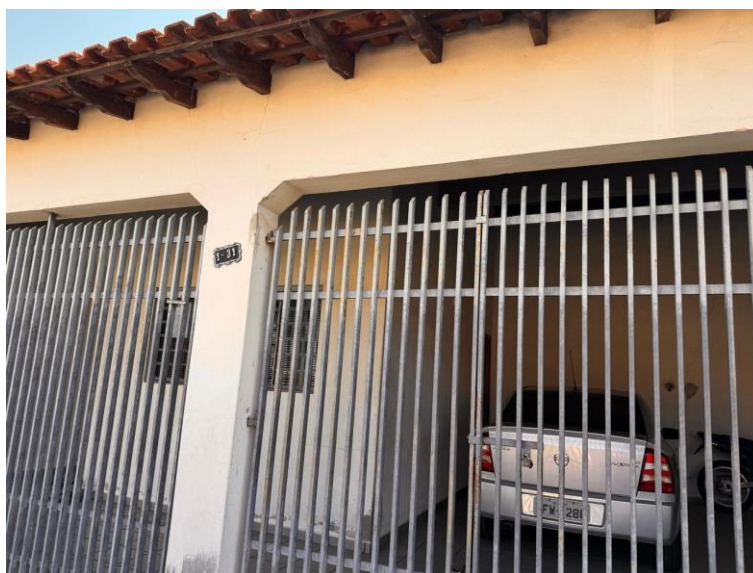
Foto 01. Elevação principal do imóvel.
