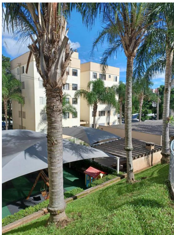
FOTO 1 – FACHADA DO CONDOMÍNIO
